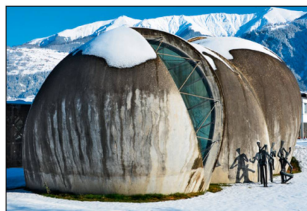
Les coques en béton de l'église de Cazis (source: graubuenden.ch)
