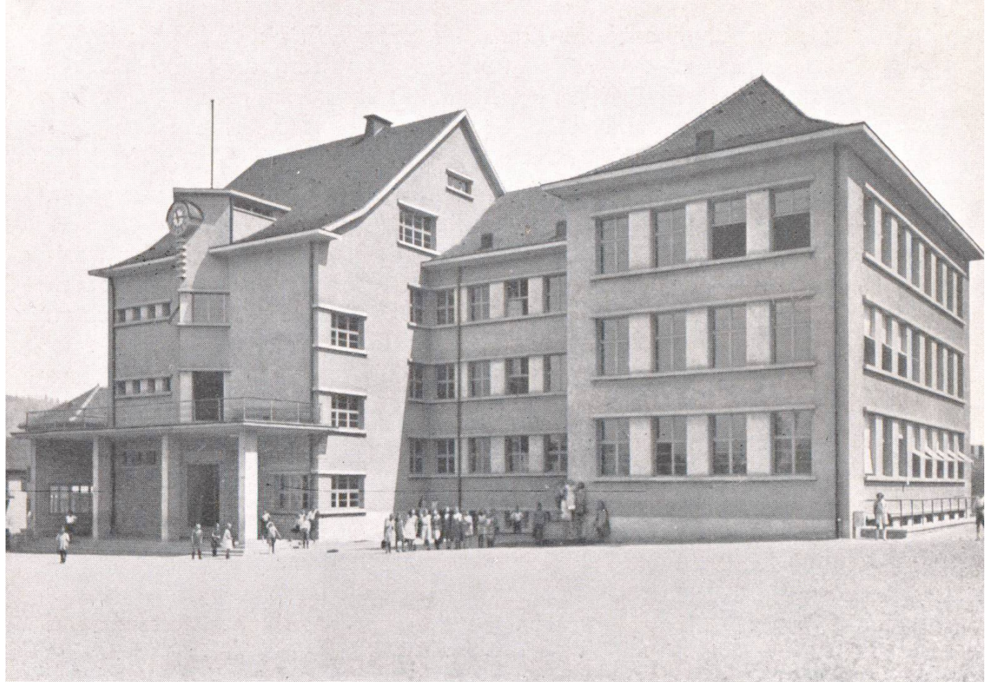
Schulhaus in Schlieren (Unternehmung Ed. Züblin & Co. A.G., Zürich) Fassadenverputz aus hydraulischem Kalk-Mörtel
