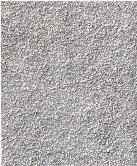
Gut ausgeführter Verputz (Kellenwurf)
