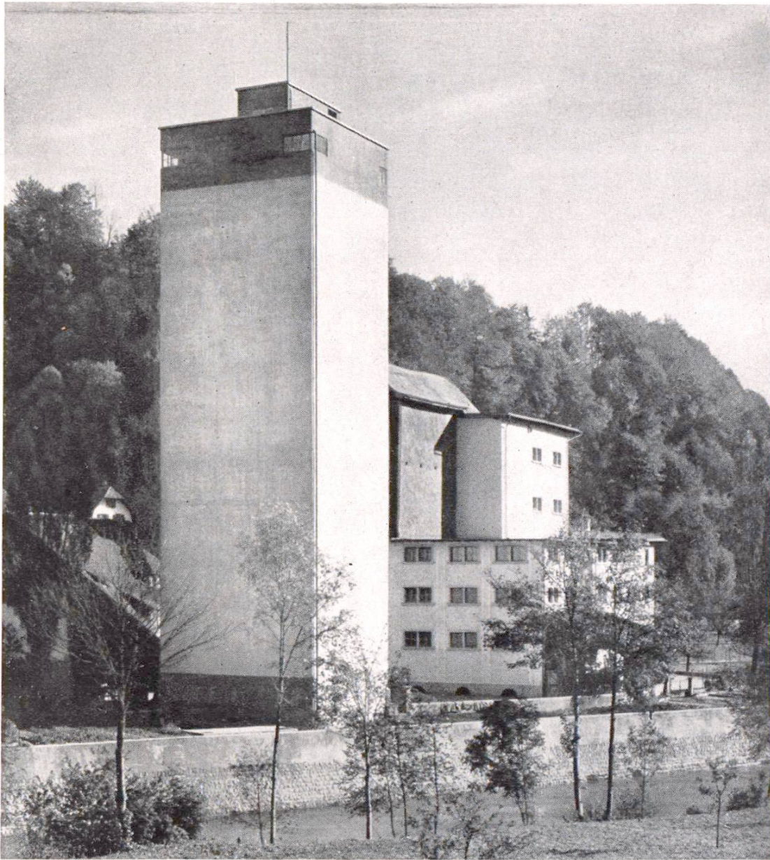
Abb. 3 Walzmühle in Wolhusen
