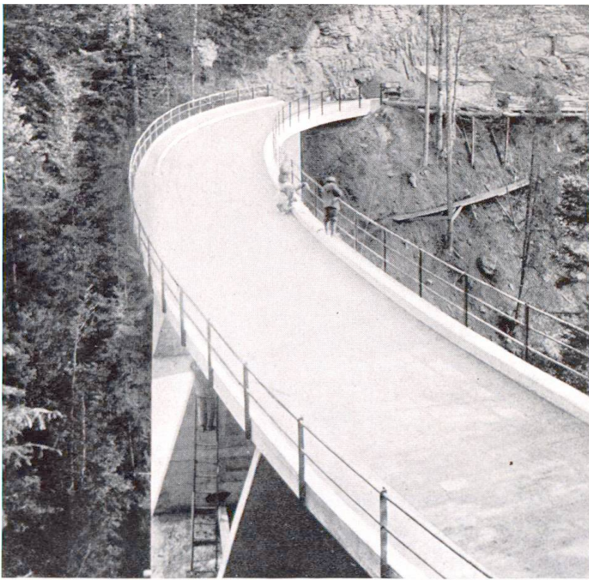
Abb. 6 Schwandbachbrücke bei Schwarzenburg (1933) Ausführung: Losinger & Cie. A.-G. und E. & H. Binggeli
