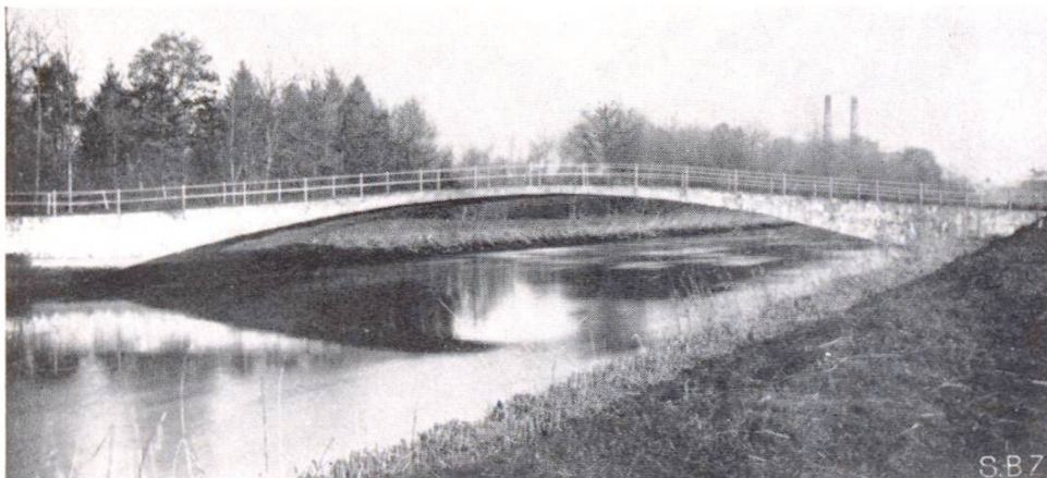
Abb. 1 Strassenbrücke über den Aarekanal der Jura-Cement-Fabriken in Wildegg (1890)
