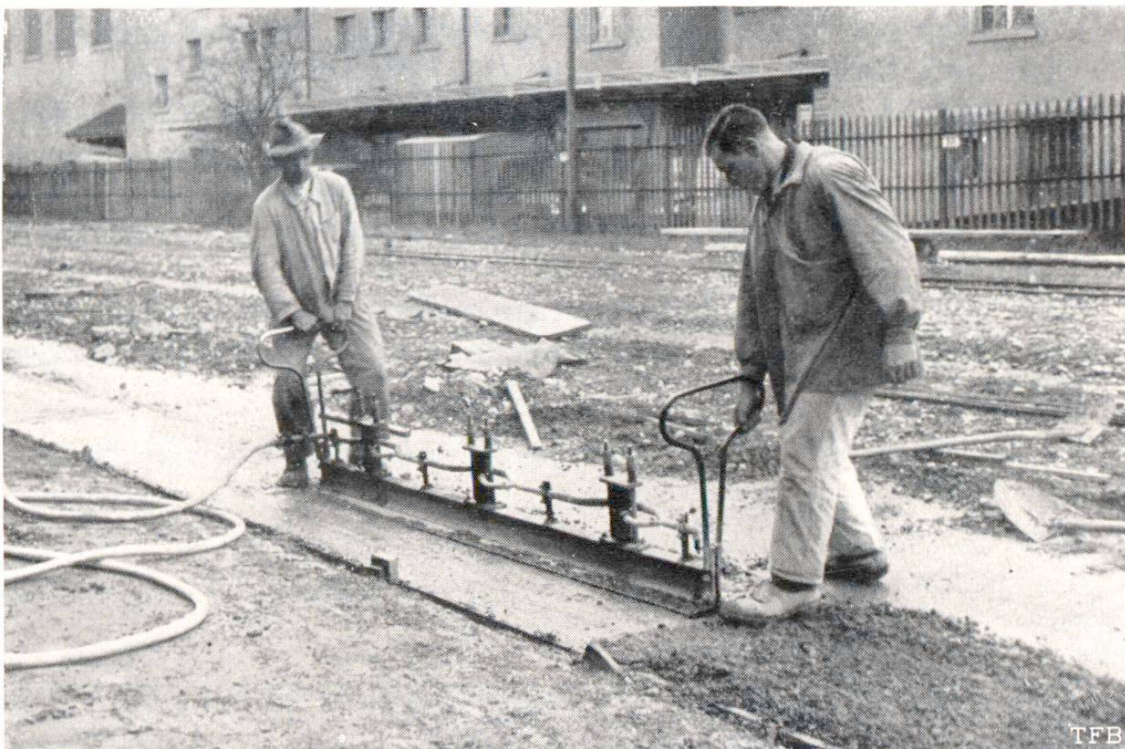
Abb. 1 Oberflächliche Vibration mit dem «Vibropil» - bei einer Betonstrasse im Güterbahnhof Zürich - Bauleitung: Betonstrassen A.-G., Wildeg; Unternehmung: Prader & Cie., A.-G., Zürich.
