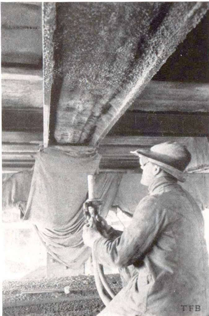
Abb. 3 Gunitieren der Untergurte
