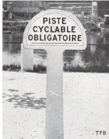
Abb. 4 Markierung eines Radfahrerweges durch einen Betonpfosten mit Aufschrift.
