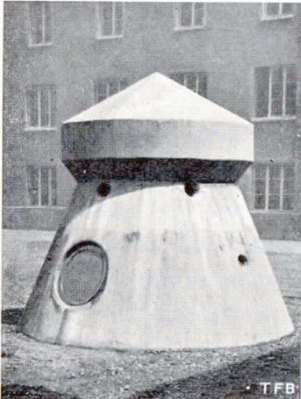
Abb. 1 Beobachtungsstand des Kleinschutzturmes «Schindler».
