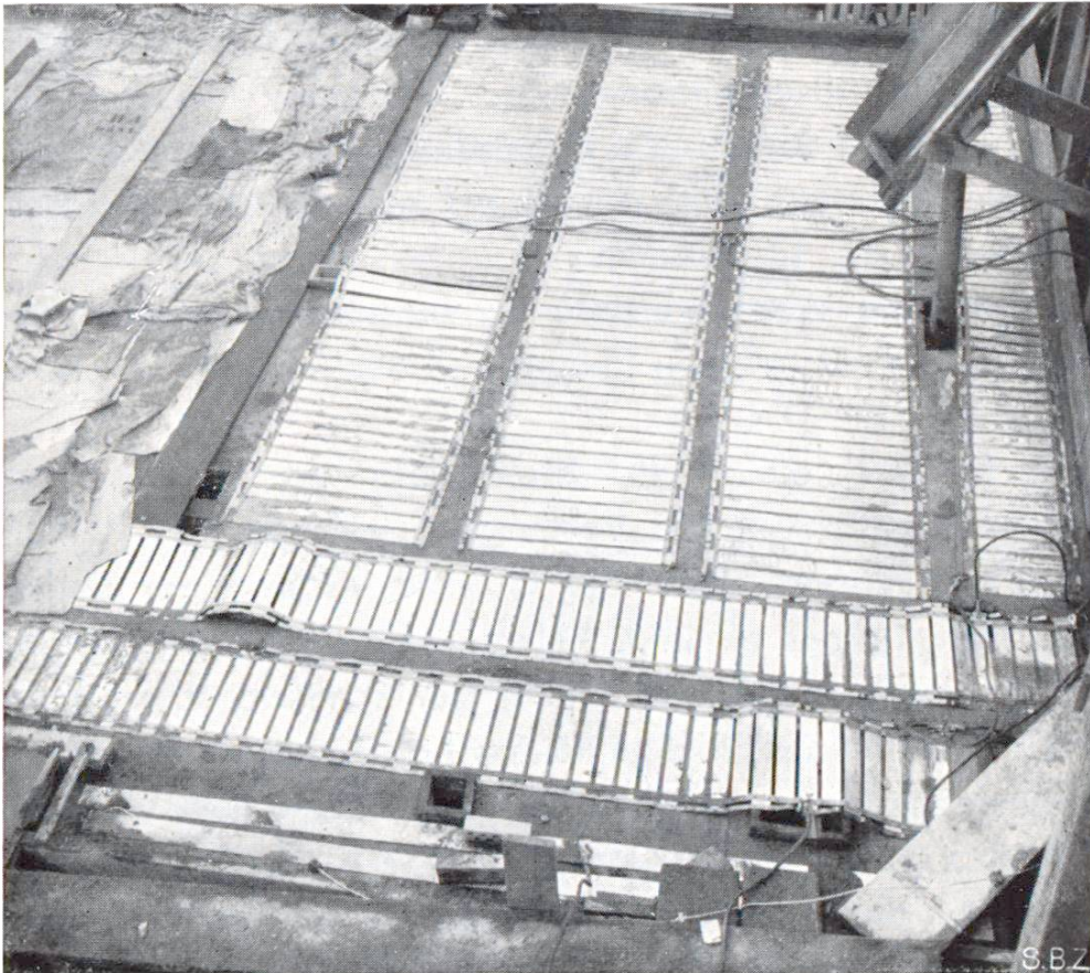
Abb. 2 Elektrodeuteppich auf einer frisch betonierten Eisenbetondecke (Baugenossenschaft „Hirse“ in Zürich).
