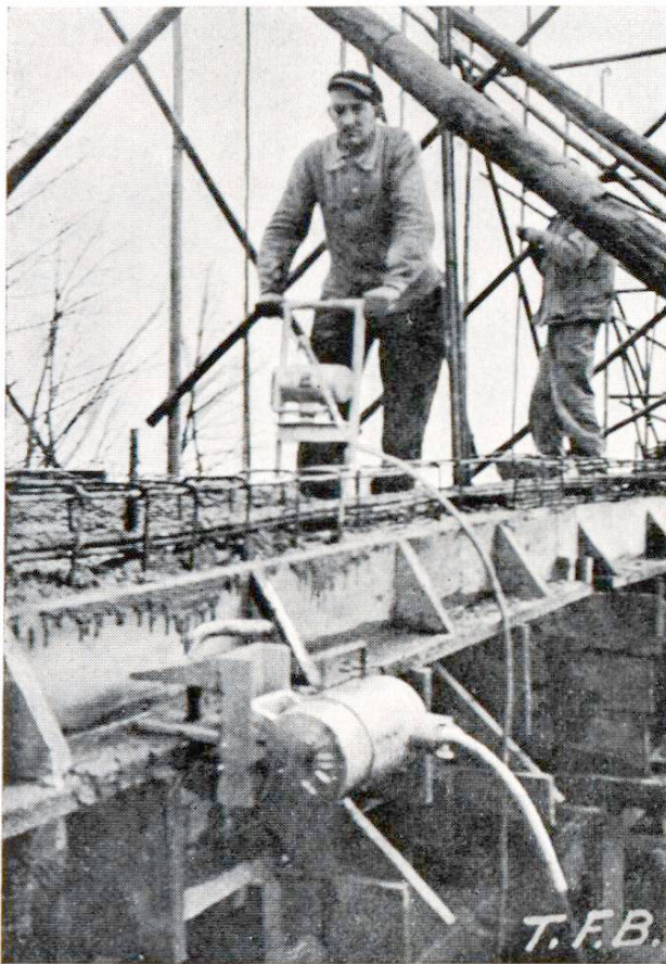
Abb. 2 Aussenvibration mittels der Vibrierhebel und eines an der Seitenschalung befestigten Elektro-Vibrators.
