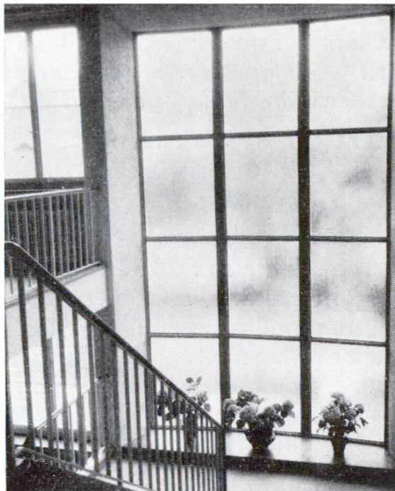
Abb. 4. Das grosse Fenster mit Befonspossen im Treppenhaus.
