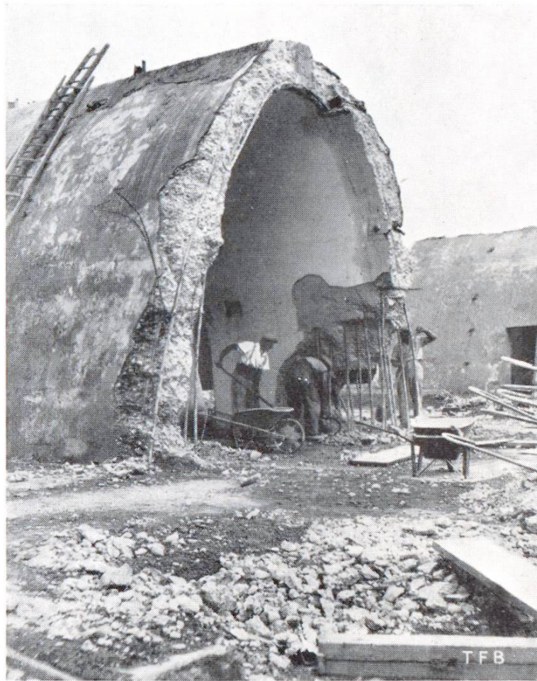
Abb. 4 Abbruch eines armierten Betongewölbes mittelst Abbauhämmern.
