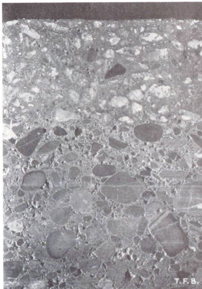
Abb. 5 Probe aus Strassenbelag. Die Verschleißschicht enthält zur Verminderung der Abnutzung Granitsplitt.
