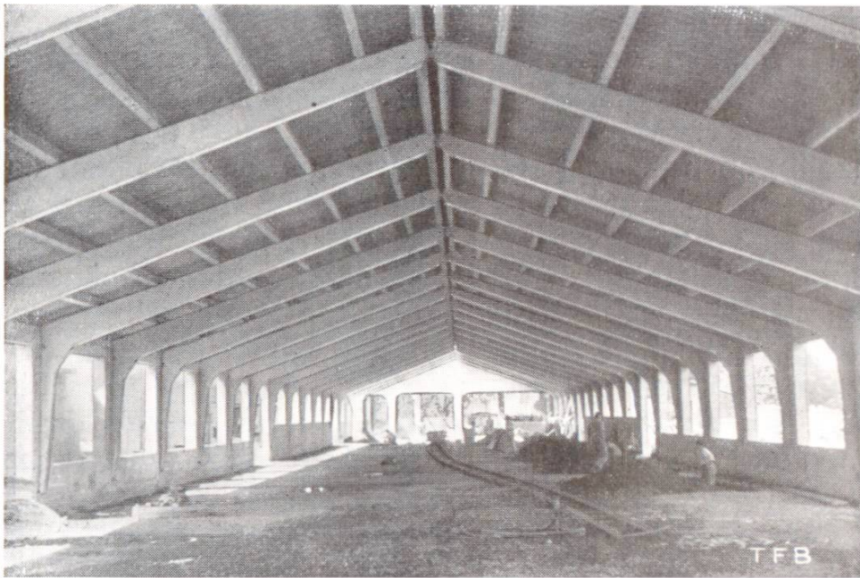
Abb. 3 Dachuntersicht nach der Eindeckung mit Welleternit
