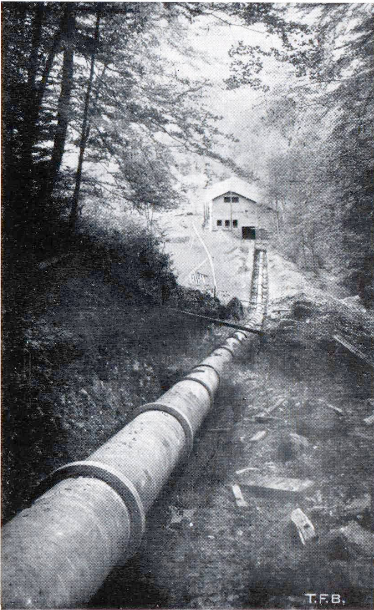
Abb. 3 Kombinierte Druckleitung Beton-Eisen
