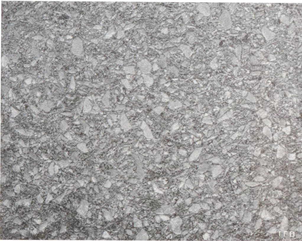
Abb. 4 Betonsichtfläche, 24 Stunden nach dem Einbringen des Betons mit Sandstrahl behandelt und roh abgeschliffen
