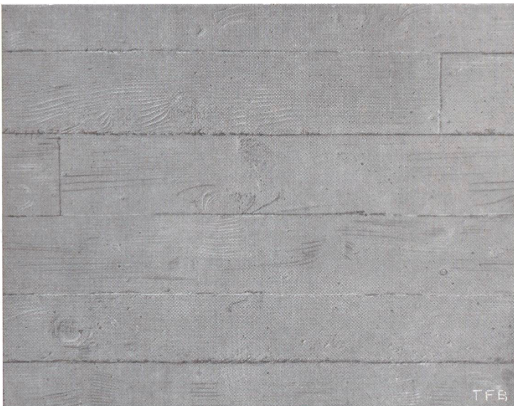
Abb. 1 Sichtbeton aus gehobelter Schalung, mit Mineralfarbe gestrichen
