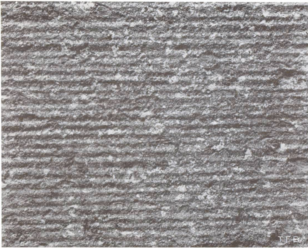
Abb. 5 Bearbeitung des Betons durch Riffelschlag
