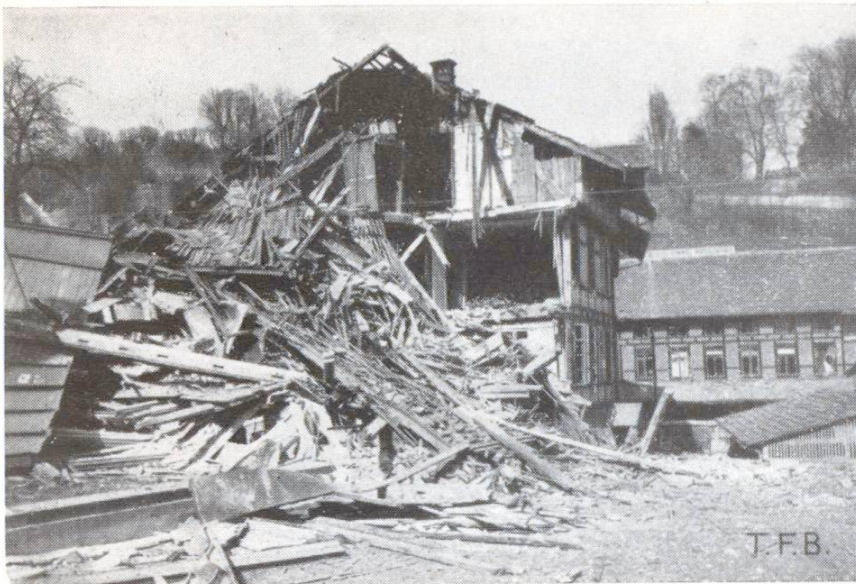
Abb. 3 Explosionswirkung auf Riegelbauwerk
