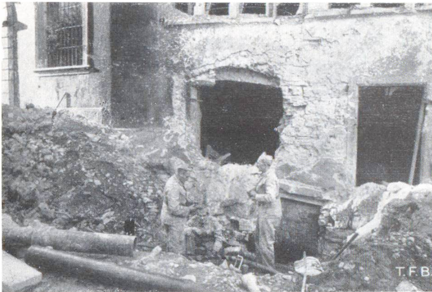
Abb. 5 Splitterwirkung auf Massivbau
