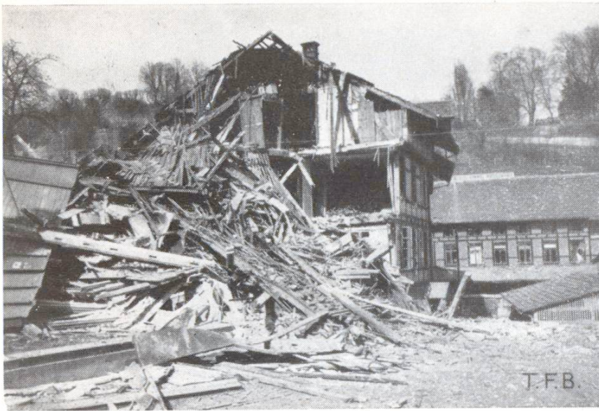
Abb. 3 Explosionswirkung auf Riegelbauwerk
