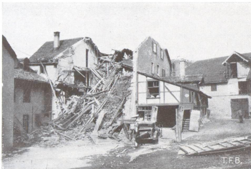
Abb. 2 Explosionswirkung auf Wohnhaus aus Bruchstein und Zie- gelmauerwerk
