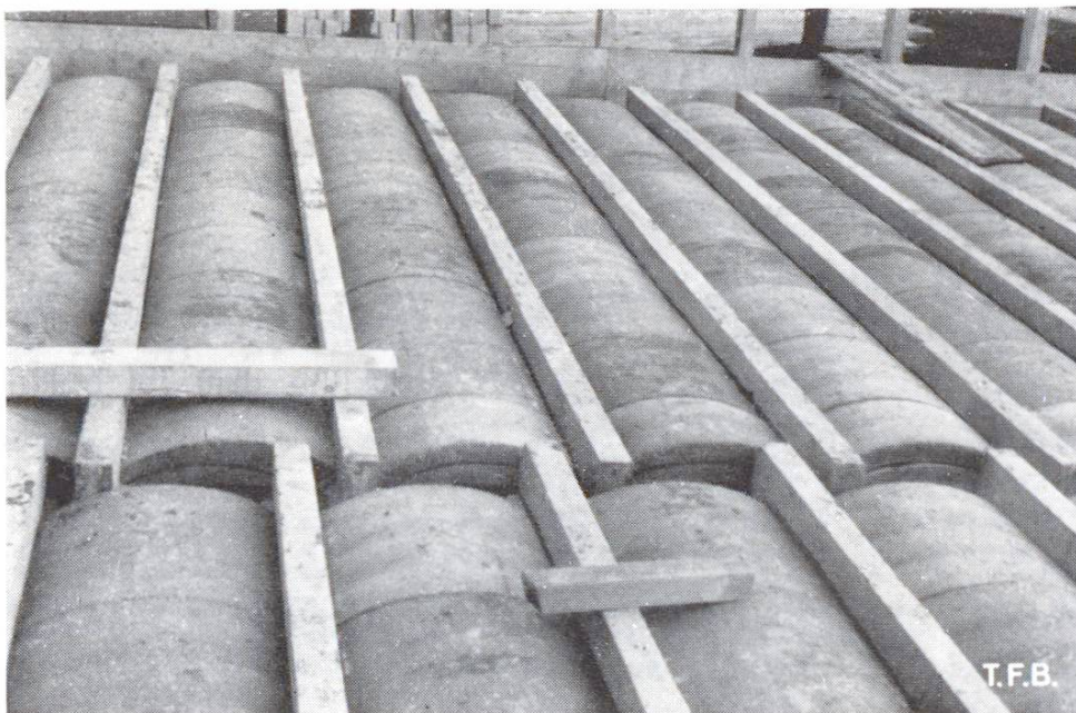
Abb. 3 Deckenkonstruktion aus vorgespannten Fertigbalken und Betonhourdis
