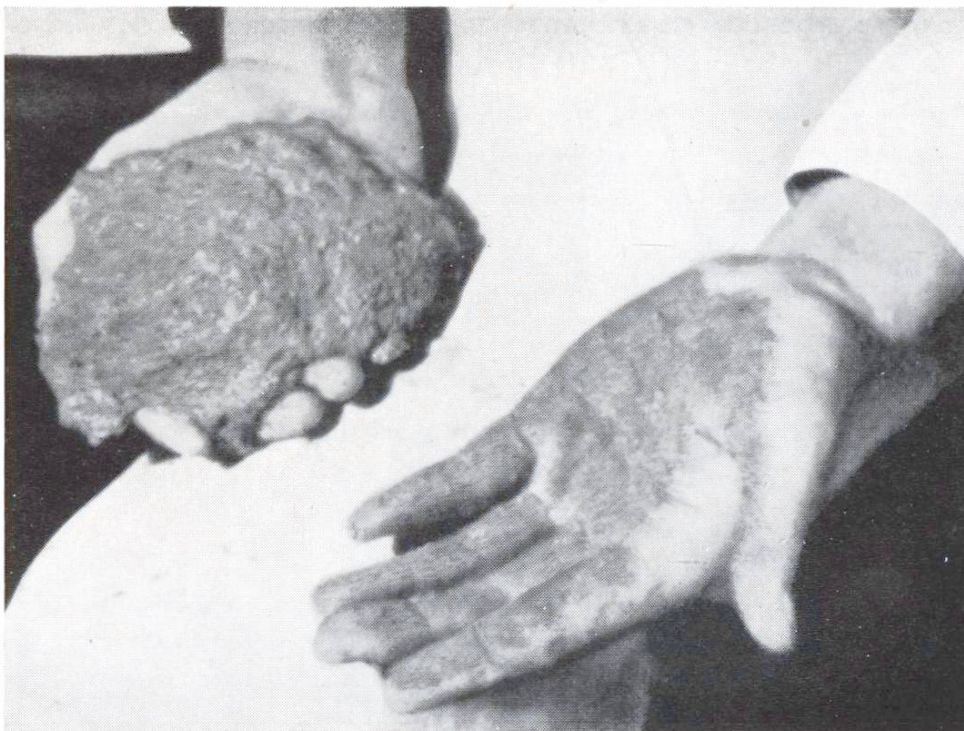
Abb. 2 Handprobe: Bildsamkeit (Plastizität), Klebrigkeit etc. lassen sich hierbei leicht erkennen. Erdfeuchter Beton soll sich gerade noch ballen lassen, aber bei leichtem Druck auseinanderfallen. Plastischer Beton soll sich hierbei wie ein steifer Teig verhalten. (Fig. aus Cem. & Conc. Ass., s. Lit.)
