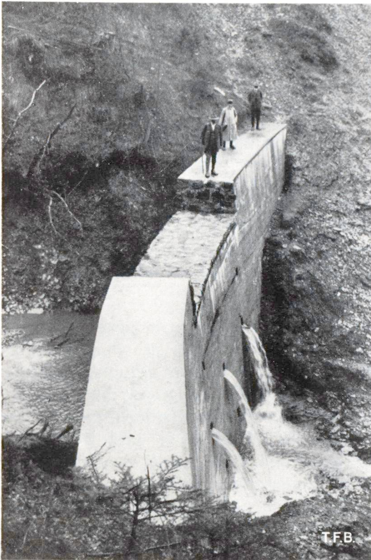
Abb. 5 Sperre in Beton mit Natursteinverkleidung des Überlaufes, kurz nach Bauvollendung; heute mit Gesschiebe hinterfüllt; Trübbach bei Trübbach, Kanton St. Gallen
