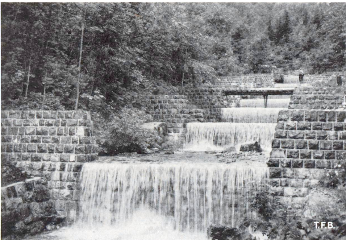
Abb. 2 Sperren in Cementmörtelmauerwerk aus Natursteinen am Dürrenbach, Stein, Toggenburg
