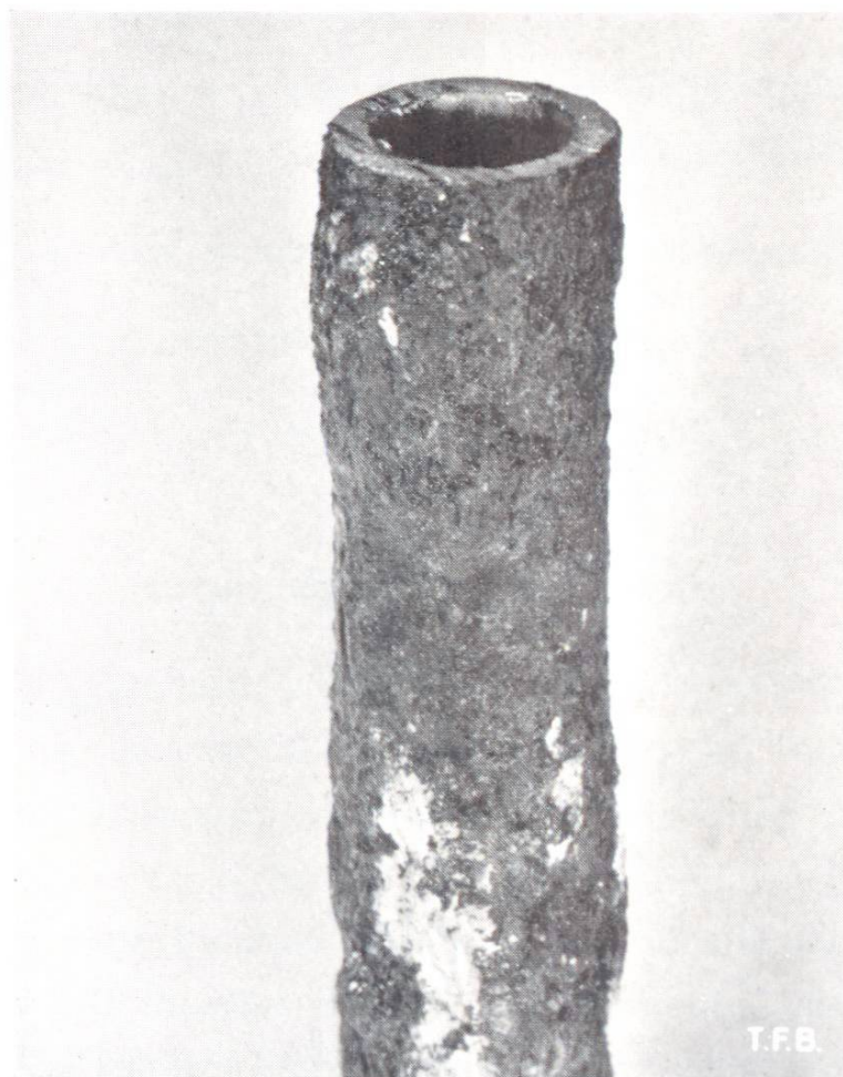
Abb. 3 Korrosionserscheinungen an Bleirohr, verursacht durch den benachbarten Mörtel. Der Angriff erfolgte stufenweise, wie aus den verschiedenfarbigen Oxydschichten (gelbes und rotes Bleioxyd) hervorgeht.
