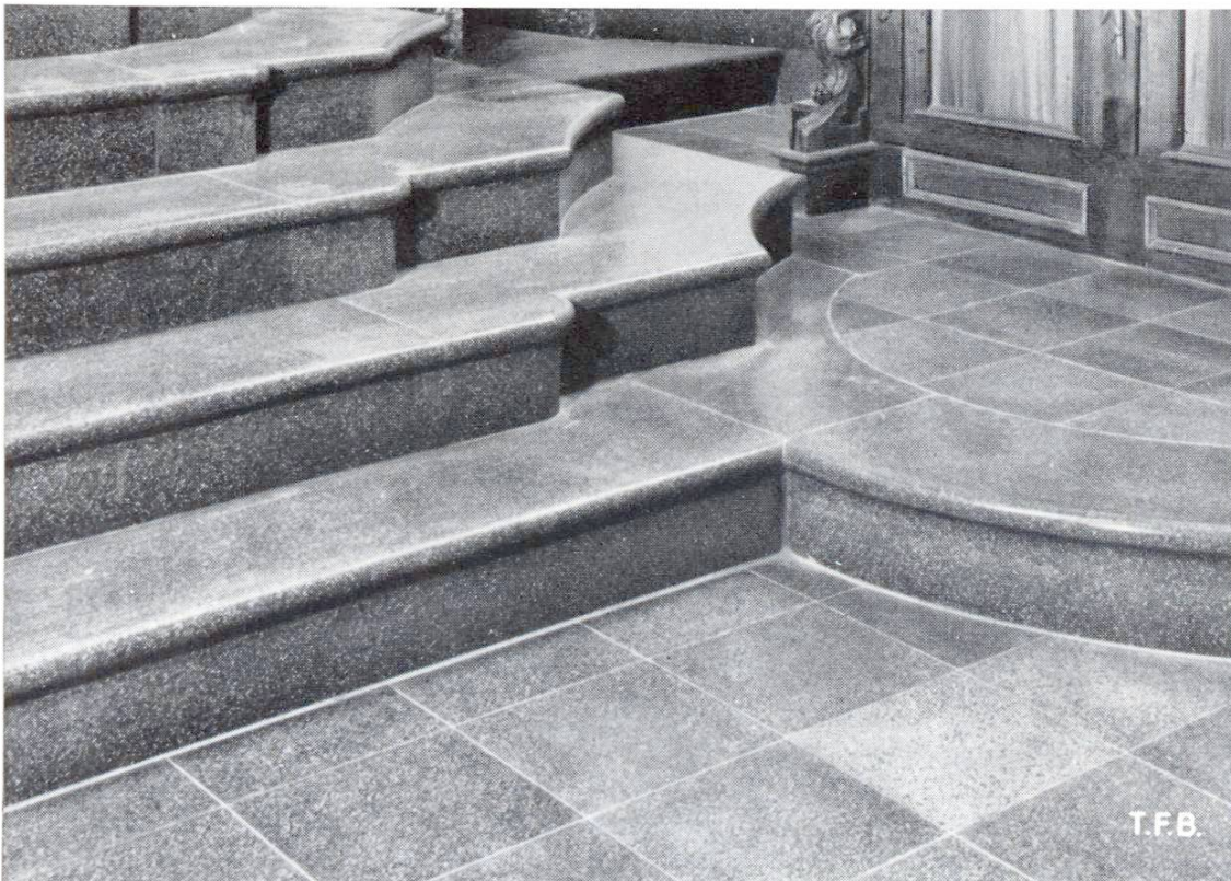
Abb. 6 Bodenbelag und Treppen aus Kunststein
