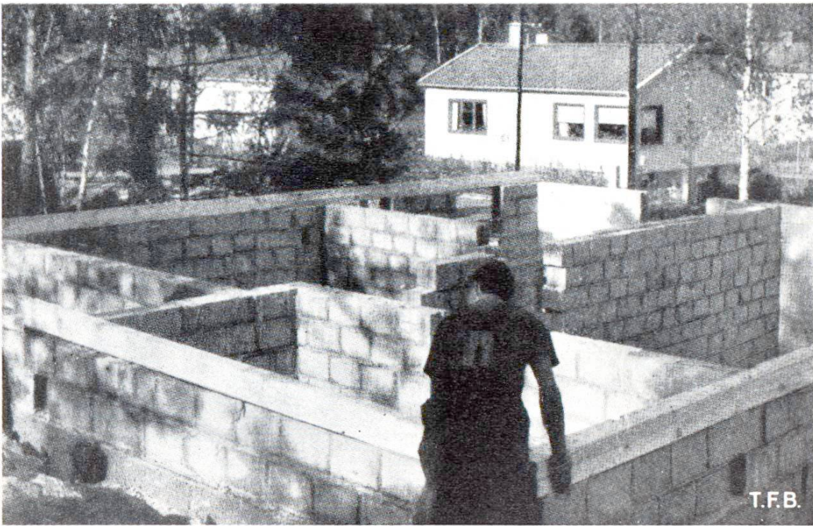
Abb. 11 Bau mit Betonhohlblöcken in einer Siedlung
