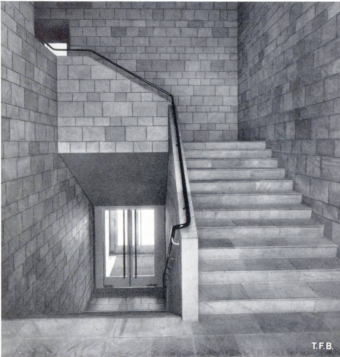
Abb. 2 Wand-, Boden- und Treppenbeläge in Naturstein
