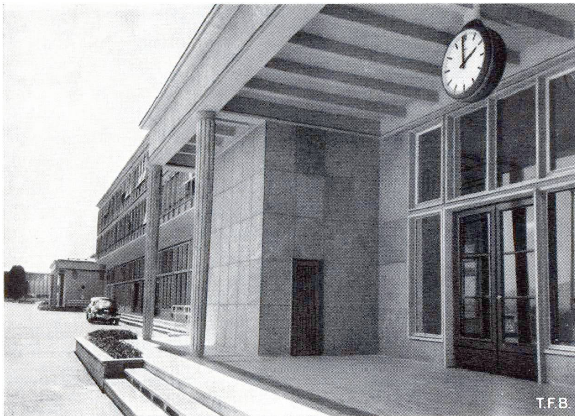
Die beiden Eingänge zu den Hallen „Départ Etranger“ (im Vordergrund) und „Départ Suisse“ (im Hintergrund) flankieren das Hauptgebäude, wo sich über dem Verbindungsgang im 1. und 2. Stock die Bureaux befinden
