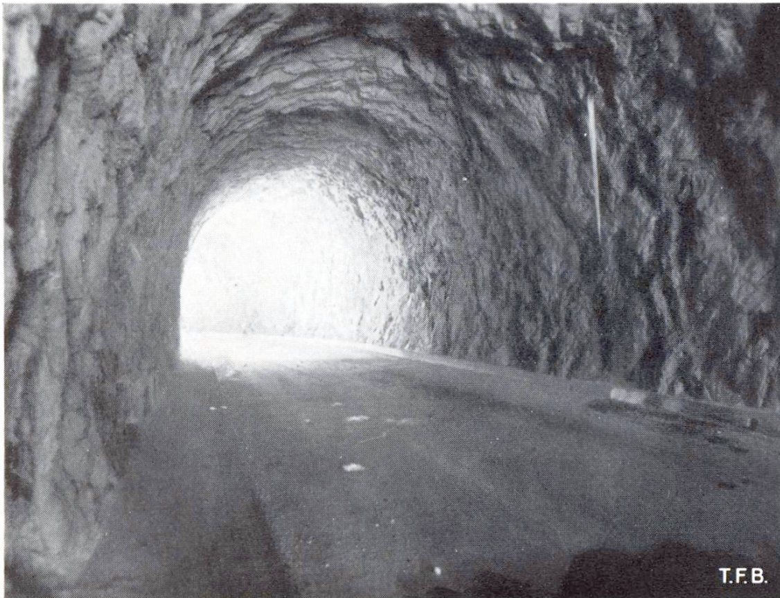
Abb. 5 Roher Felstunnel mit Eiszapfenbildung
