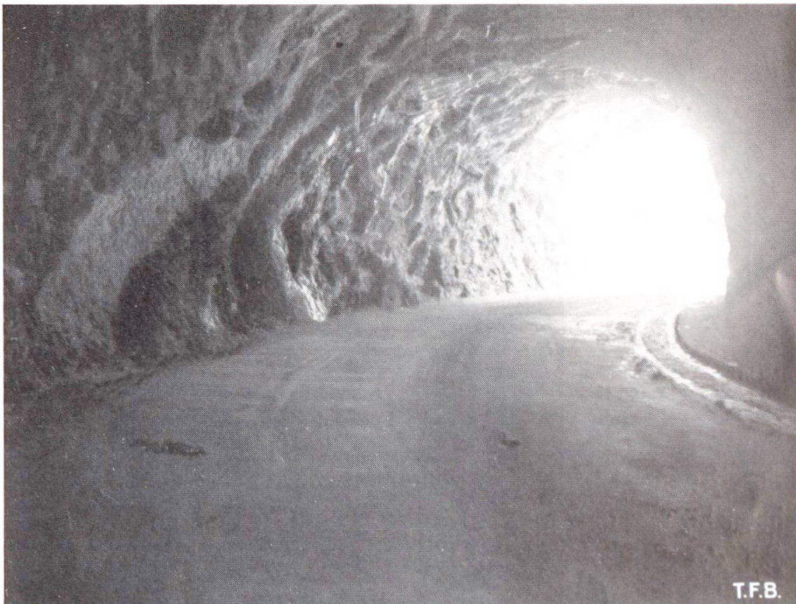
Abb. 4 Roher Felstunnel, störende Helligkeitsunterschiede und Schlagschatten
