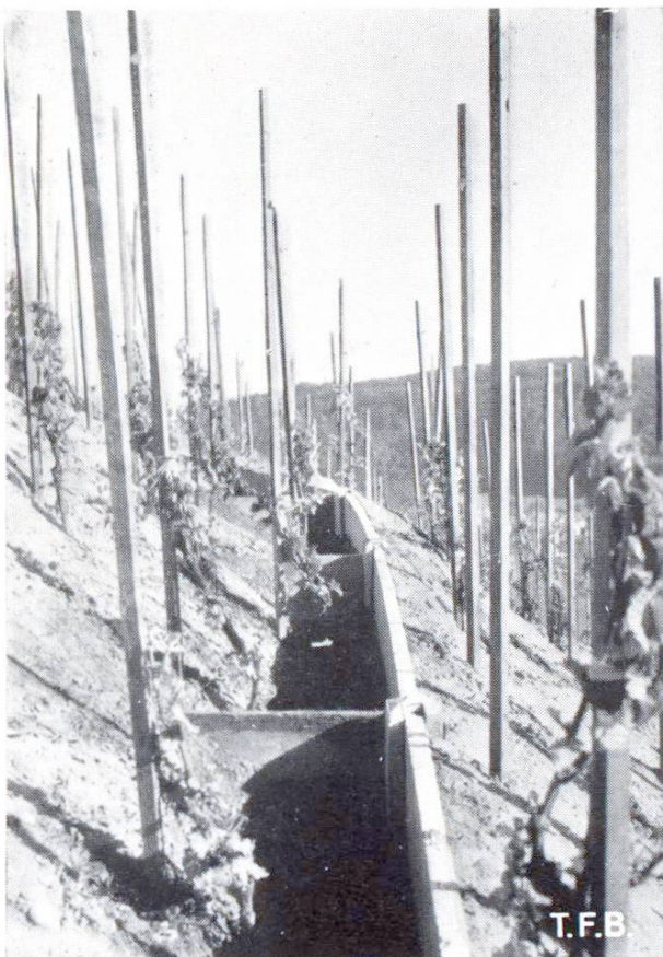
Abb. 3 Schwemmgraben mit armierten Betonschwemmbrettern gesichert, Unterteilung mit Querbrettern zur Erhöhung des Fassungsraums der Graben für Schwemmmaterial
