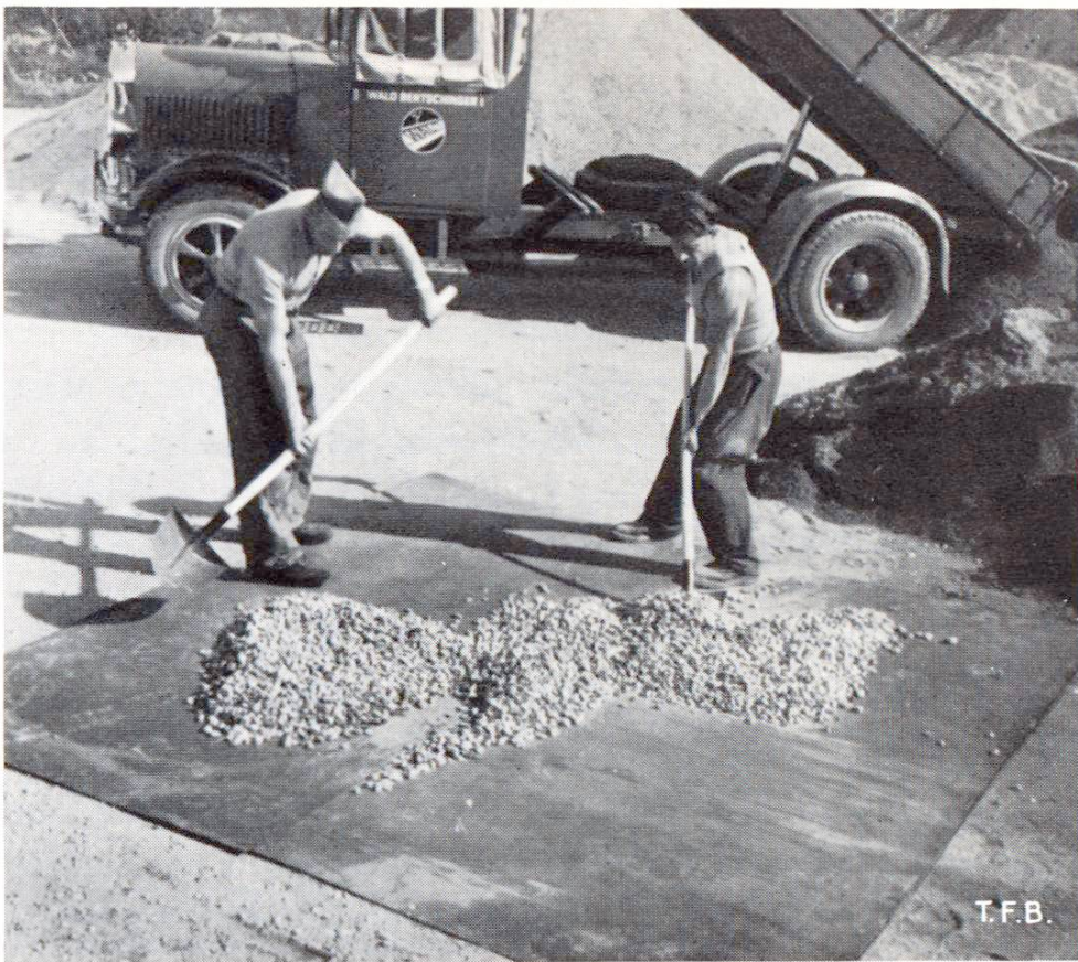
Abb. 7 Das zurückbleibende Material wird vereinigt und durchmischt
