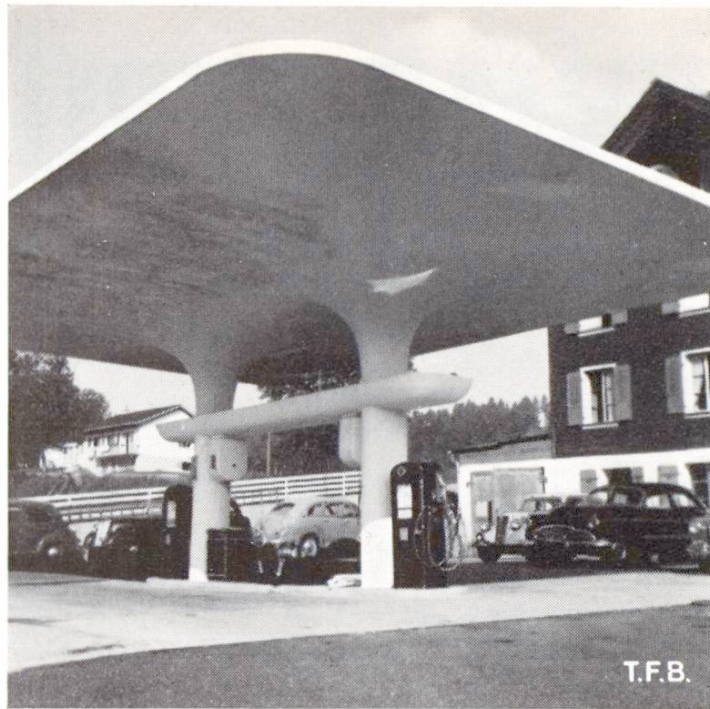
Abb. 1 Pilzköpfe mit kontinuierlichem Übergang, geschalt mit angepasster Gerüstung, Kleinholz und Gips
