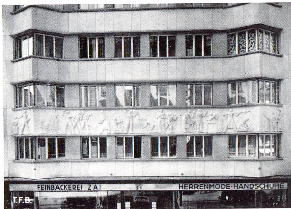
Abb. 1 Fassadenverkleidung und Reliefband aus Kunststein
