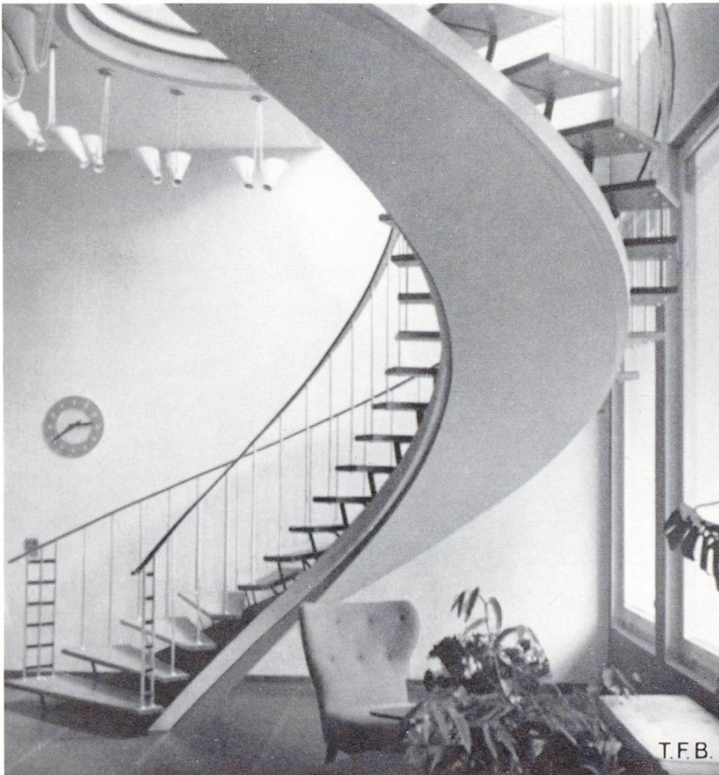
Abb. 3 Treppe in einem Verkaufsgeschäft. Auf einem Tragband aus Beton sind hölzerne Stufen befestigt
