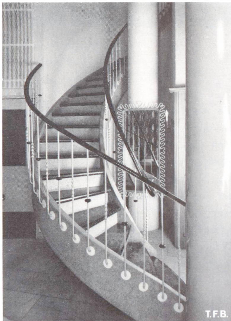
Abb. 5 Wangentreppe aus geschliffenem Kunststein in einem Restaurant. Die Stufen sind mit Gummi überzogen (Aufnahme: O. Pfeifer, Luzern)
