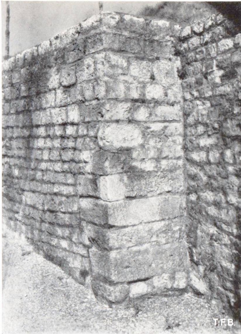
Abb. 3 Römisches Mauerwerk er- baut im 3. Jahrh. n. Chr. mit hydraulischem Kalk- mörtel. — Häuptig und lagerhaft sorgfältig be- schlagene Steine ergaben ein sehr standfestes Mauerwerk bei spar- samem Mörtelverbrauch
