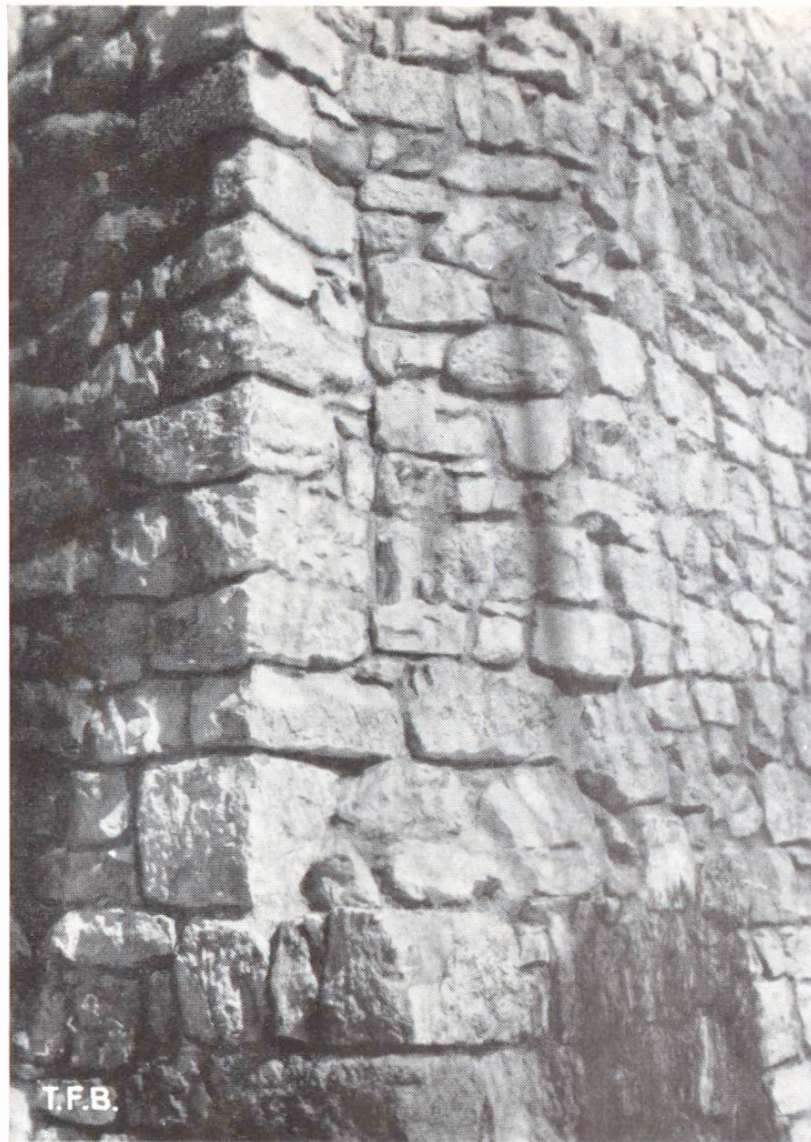
Abb. 4 Mauerwerk aus dem Mittelalter, erstellt mittels hydraulischem Kalkmörtel
