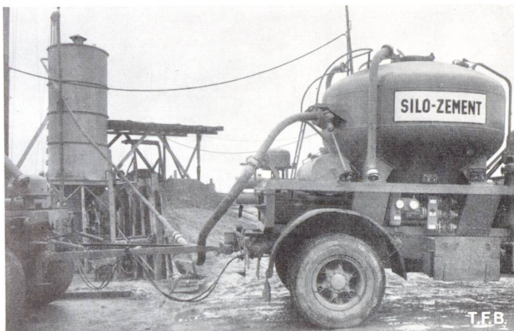
Abb. 3 Beschickung eines Baustellensilos durch Silo-Lastzug von 2 \times 5,5 t. Am Motorfahrzeug sind Instrumente und Verteilerbatterie der Pressluftanlage sichtbar
