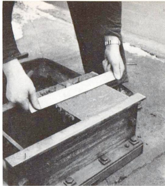
Abb. 10 Sorgfältiges Abstreichen der überstehenden Schicht bei Beginn des Anziehens
