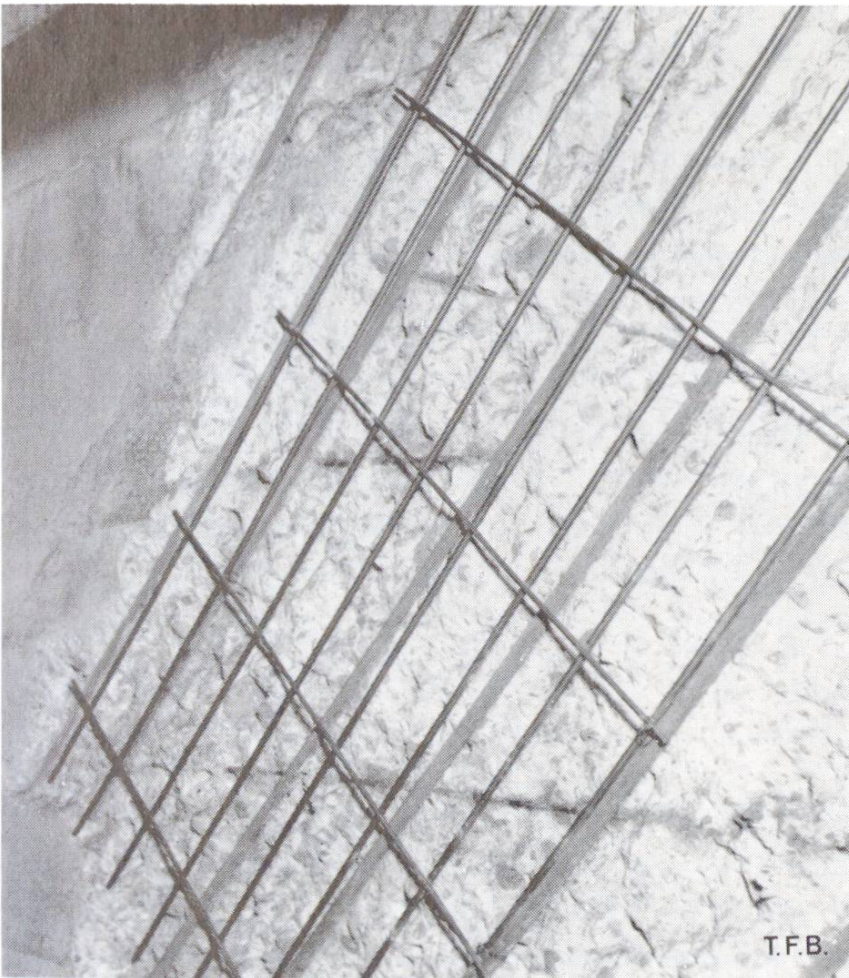
Abb. 5 Leichte Armierung einer grösseren Flächenreparatur
