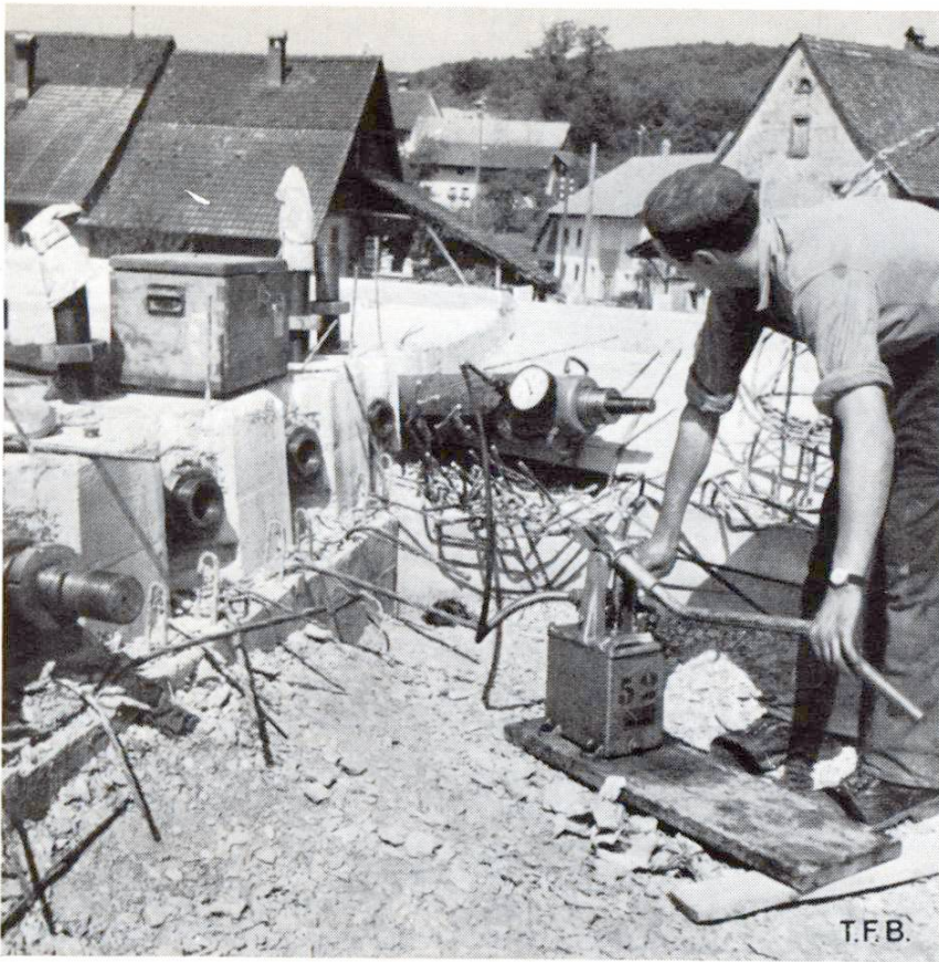
Abb. 14 Handpumpe für die Druckölspeisung einer grösseren Spann- presse
