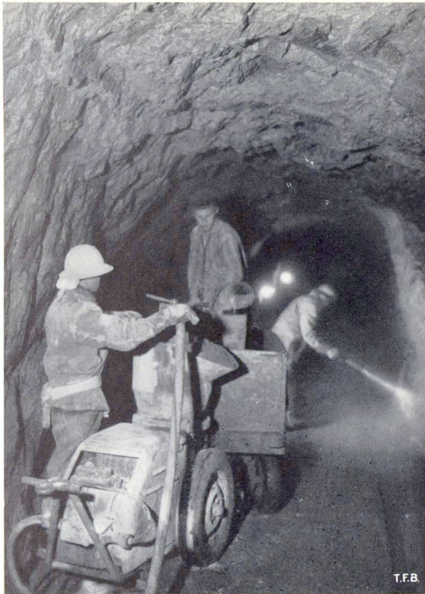
Abb. 1 Betonspritzmaschine im Einsatz beim Stollenbau
