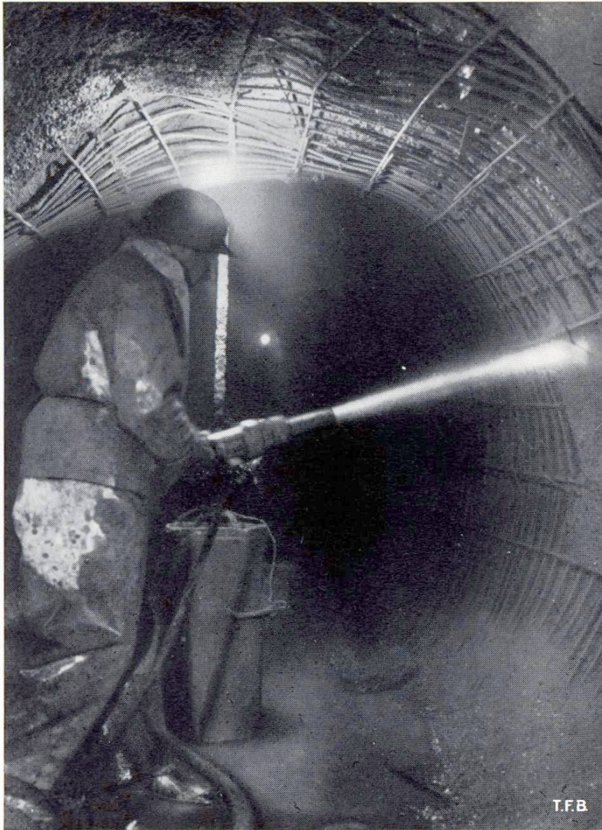
Abb. 3 Mehrschichtige armierte Stollenauskleidung bei sehr brüchigem Fels
