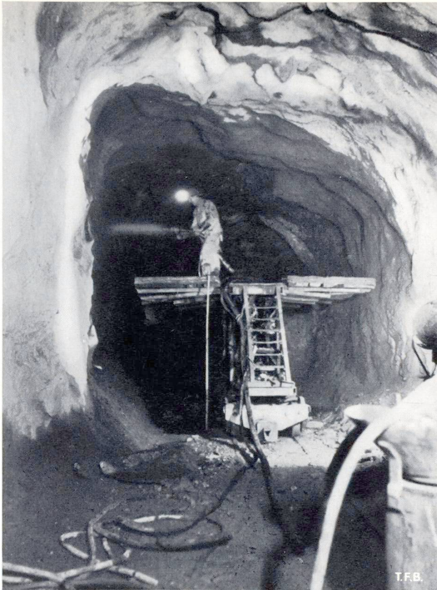
Abb. 2 Felskonsolidierung mit aufgespritztem Beton unmittelbar hinter der Stollenbrust (Aufnahme Maggia-Kraftwerke AG)
