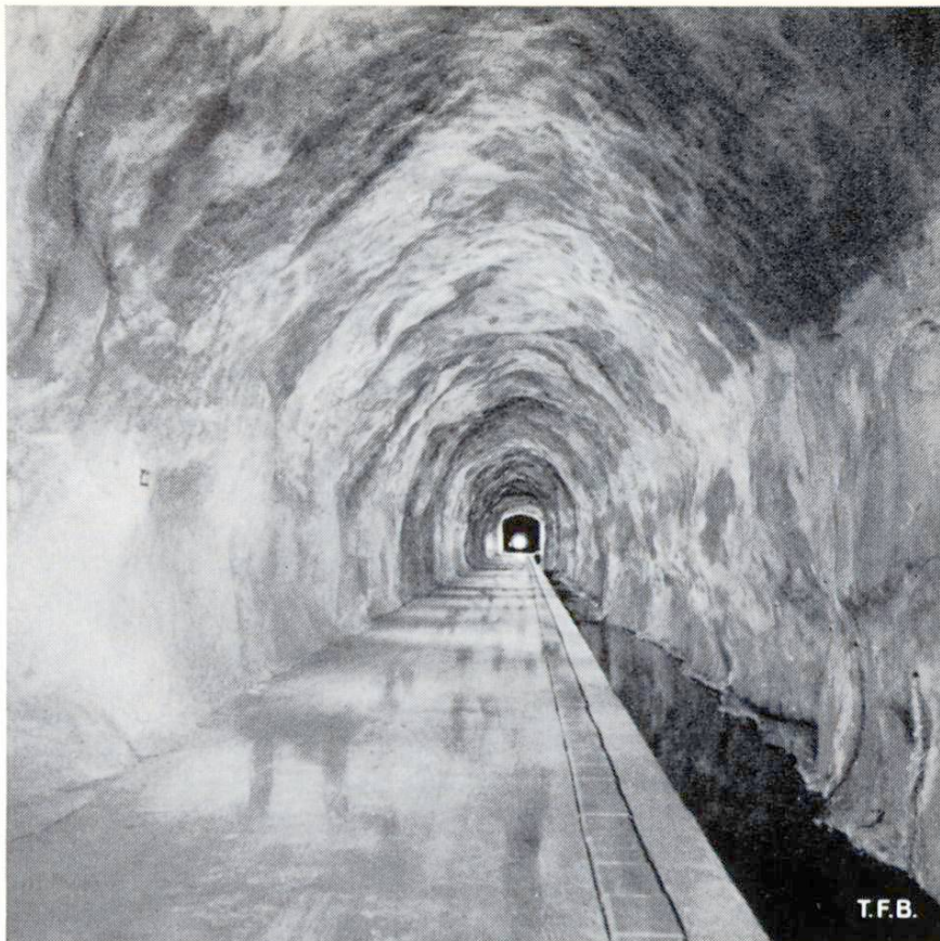
Abb. 4 Mit Spritzbeton ausgekleideter Freilaufstollen der Maggia-Kraftwerke (Aufnahme MKW)
