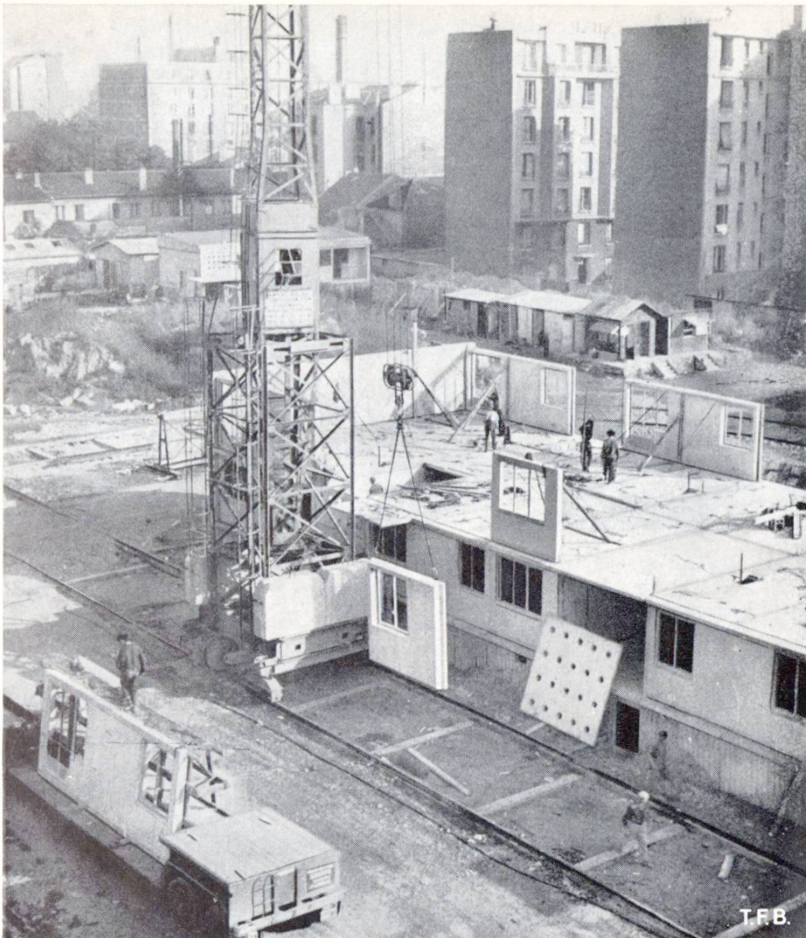
Abb. 5 Montagebau. Im Vordergrund ein Spezialfahrzeug für den Transport der Bauelemente.
