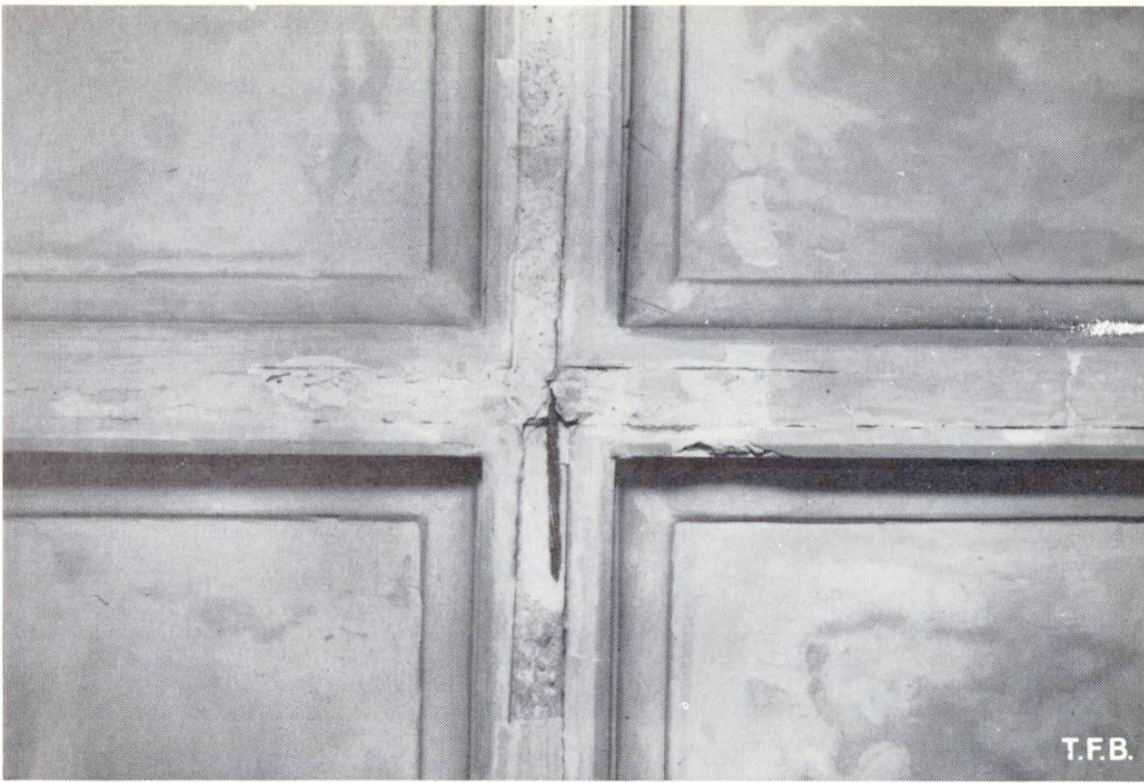
Abb. 4 Detail der modern anmutenden Deckenkonstruktion
