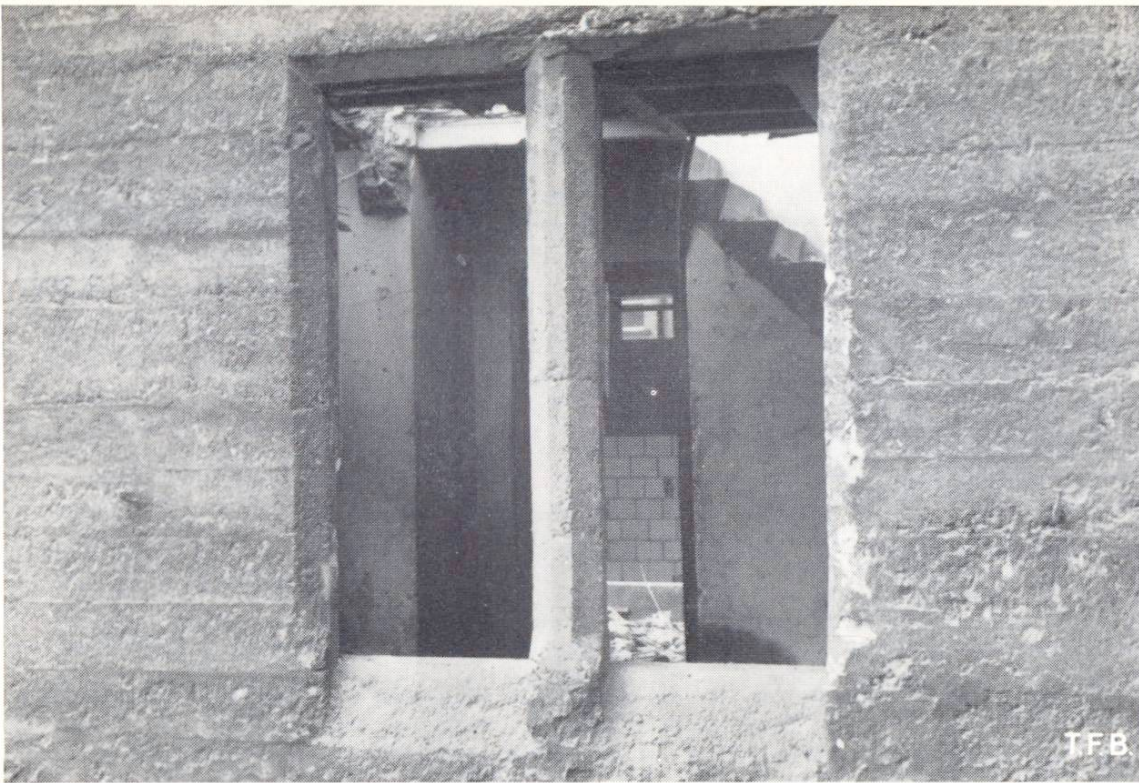
Abb. 2 Fassade mit Doppelfenster in Sichtbeton. Im Hintergrund die in Beton vorgefertigten Treppenstufen
