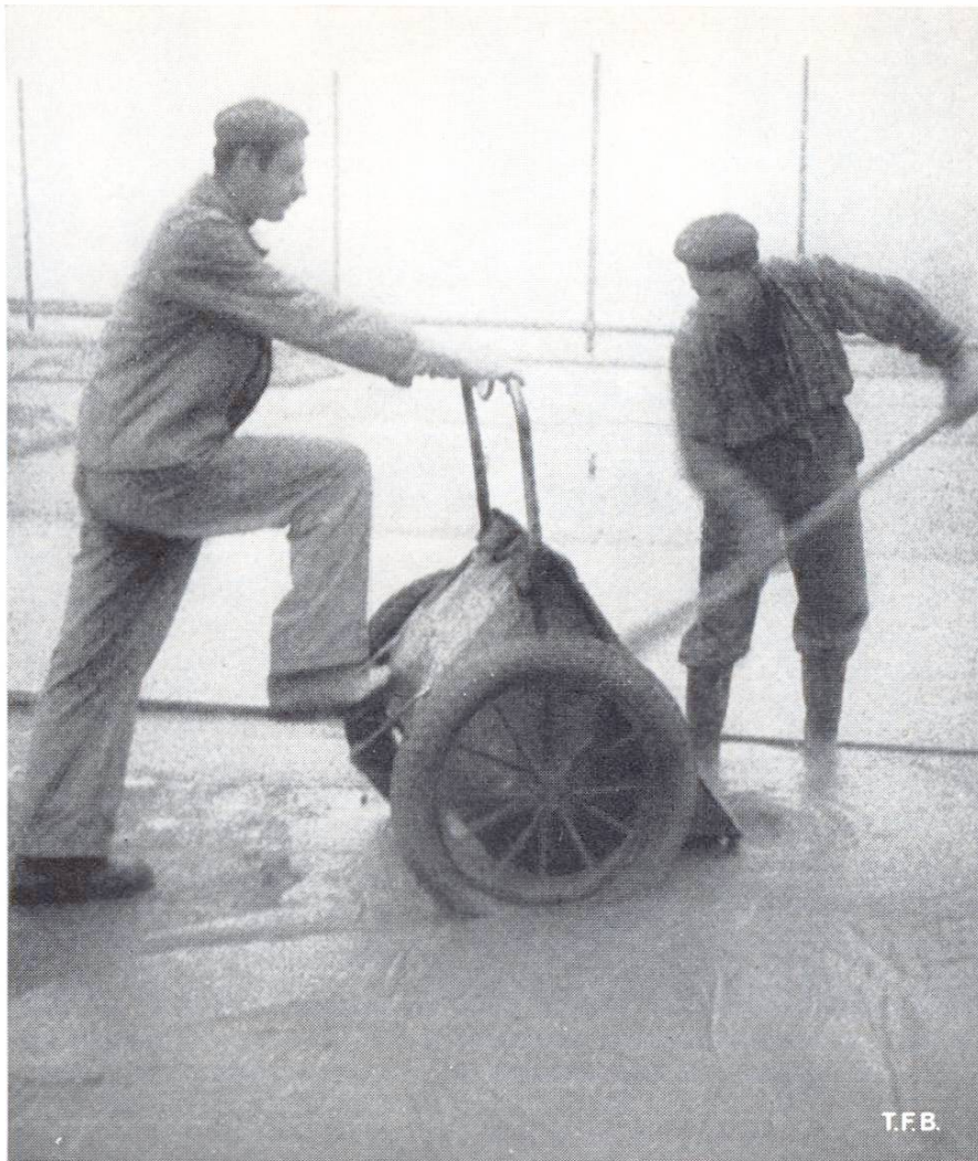
Abb. 5 Profilgerechtes Einbringen von Schaumbeton als Dachisolierung und Gefällebeton
