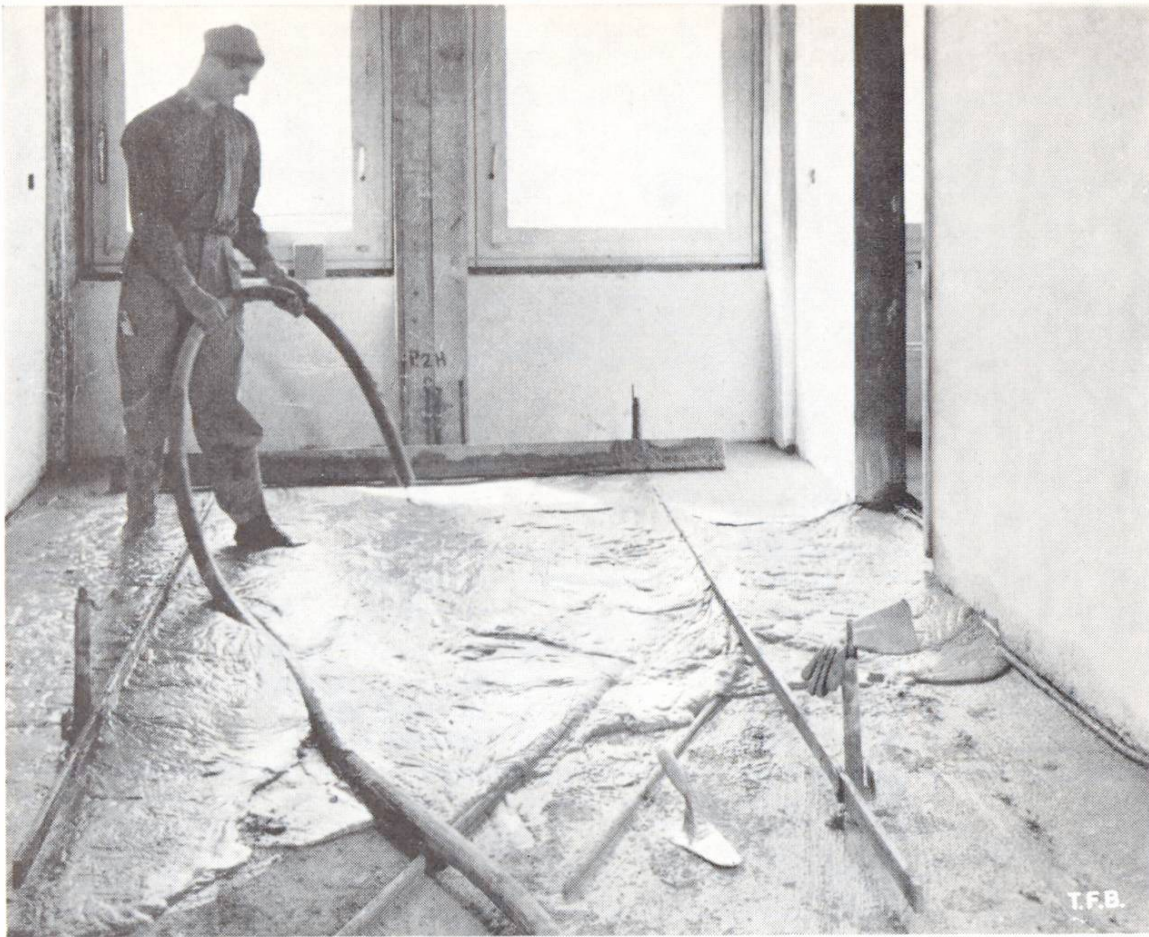
Abb. 6 Einbringen von Schaumbeton für Fussbodenisolation (Aufnahme: Engler, Winterthur).
