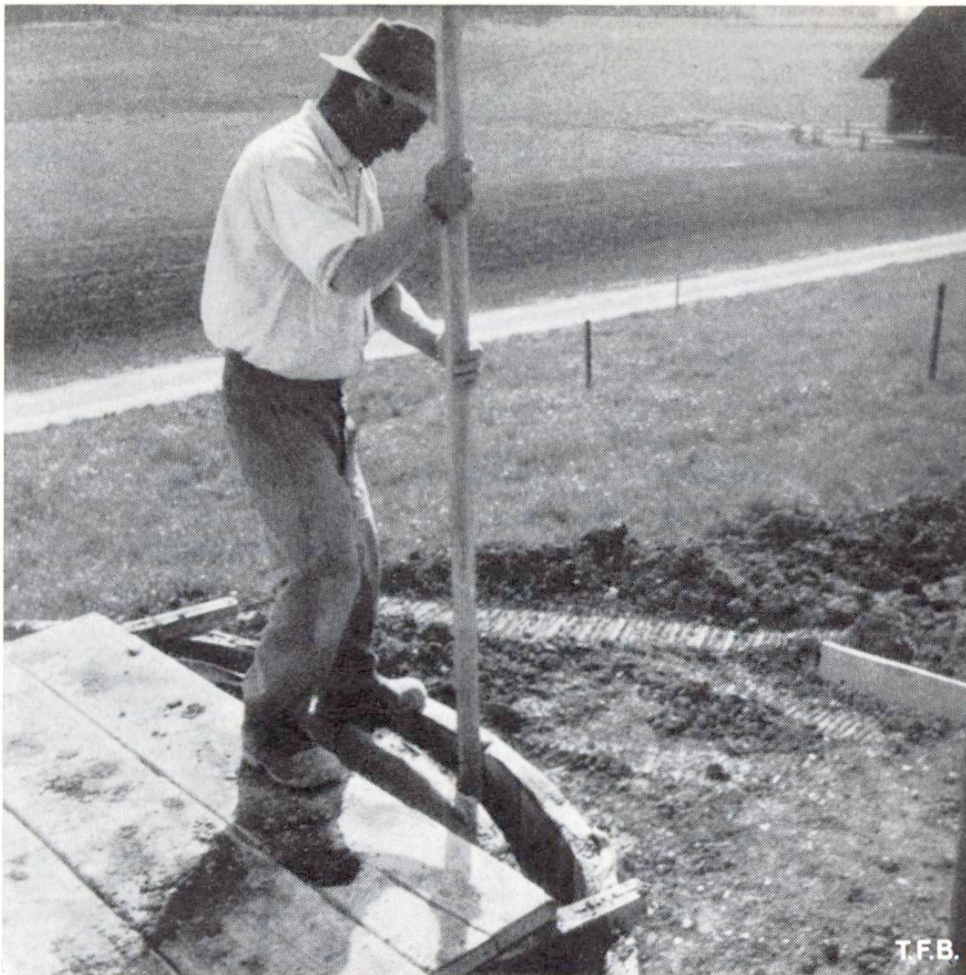
Abb. 7 Betonieren von Grünfuttersilos. Erdfeuchter bis plastischer Beton wird kräftig eingestampft
