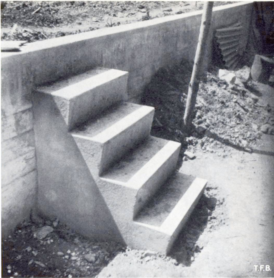
Abb. 3 und 4 Kleinere Umgebungsarbeiten in Beton
