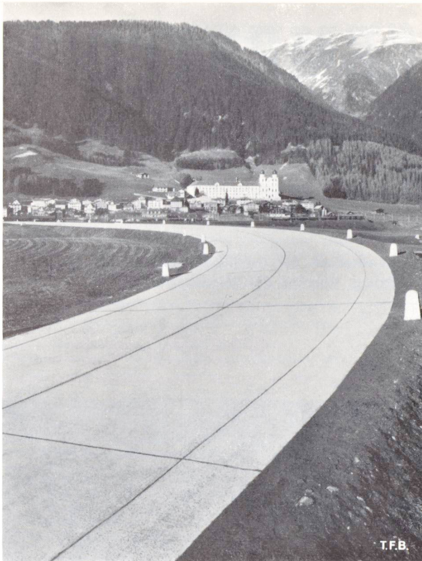
Abb. 2 Grosse Kurve bei Pt. 1126. Blick gegen Disentis. Die Strasse ist hier durch seitliche Streifen verbreitert. Die beiden mittleren Fahrbahnstreifen sind durchwegs je 3 Meter breit
