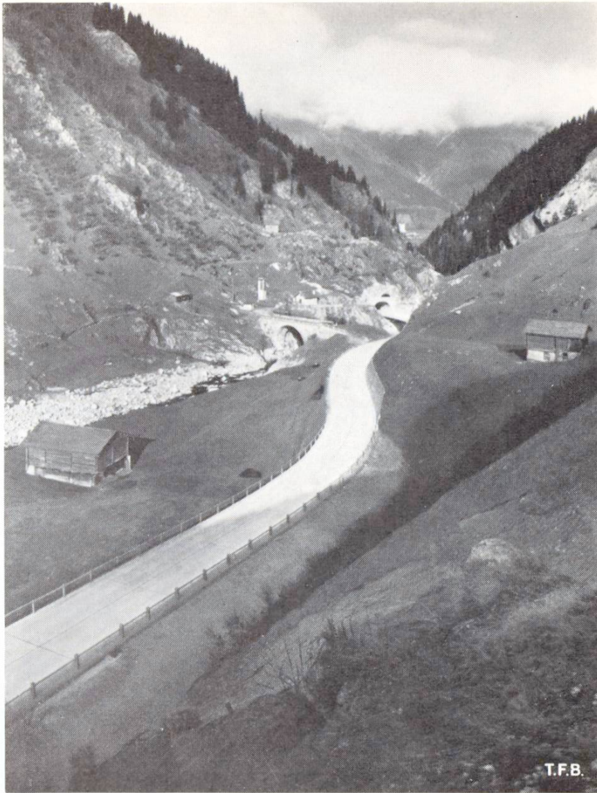
Abb. 6 Blick von unterhalb Curaglia talabwärts gegen Disentis. Alte und neue Strassenführung, Brücke und Tunnel am oberen Schluchteingang
