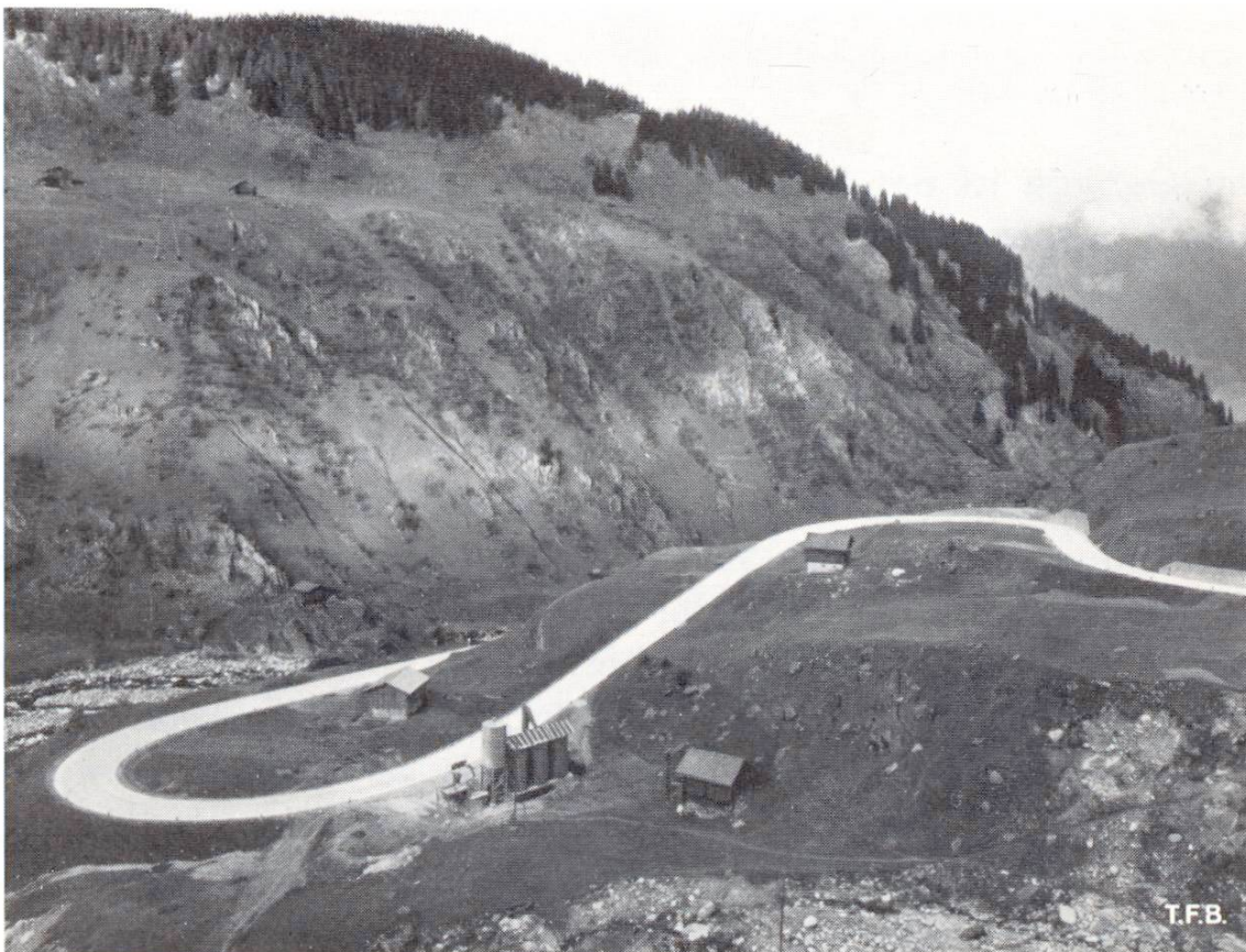
Abb. 7 Die grosse, gegenüber der alten Strasse stark erweiterte S-Kurve unterhalb Curaglia. Im Vordergrund eine Betonzentrale (Zuschlagssilo mit Becherwerk, Cementsilo, Mischmaschine und Betonsilo) für den Strassenbau
