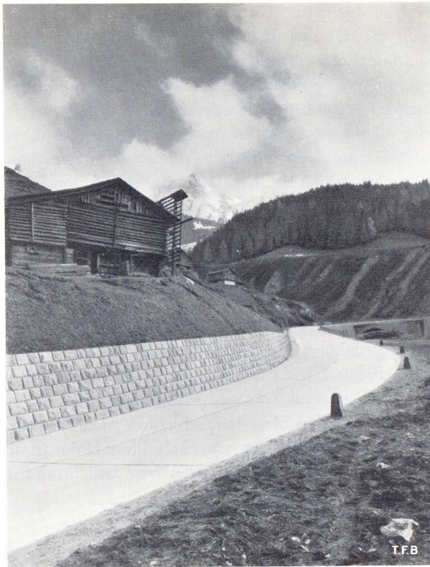
Abb. 8 Letzte Schlaufe vor Curaglia mit Brücke über den Wildbach aus der Val Plattas. Im Hintergrund der Piz Muraun, 2897 m
