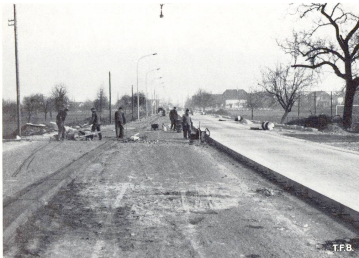
Abb. 4 Vorbereitungen zum Einbau des Betonbelages. Rechts fertiger Belag mit Ankereisen, links, neben der Planie-Ausgleichsschicht, Mörtelbett zur Aufnahme der Schalschienen
