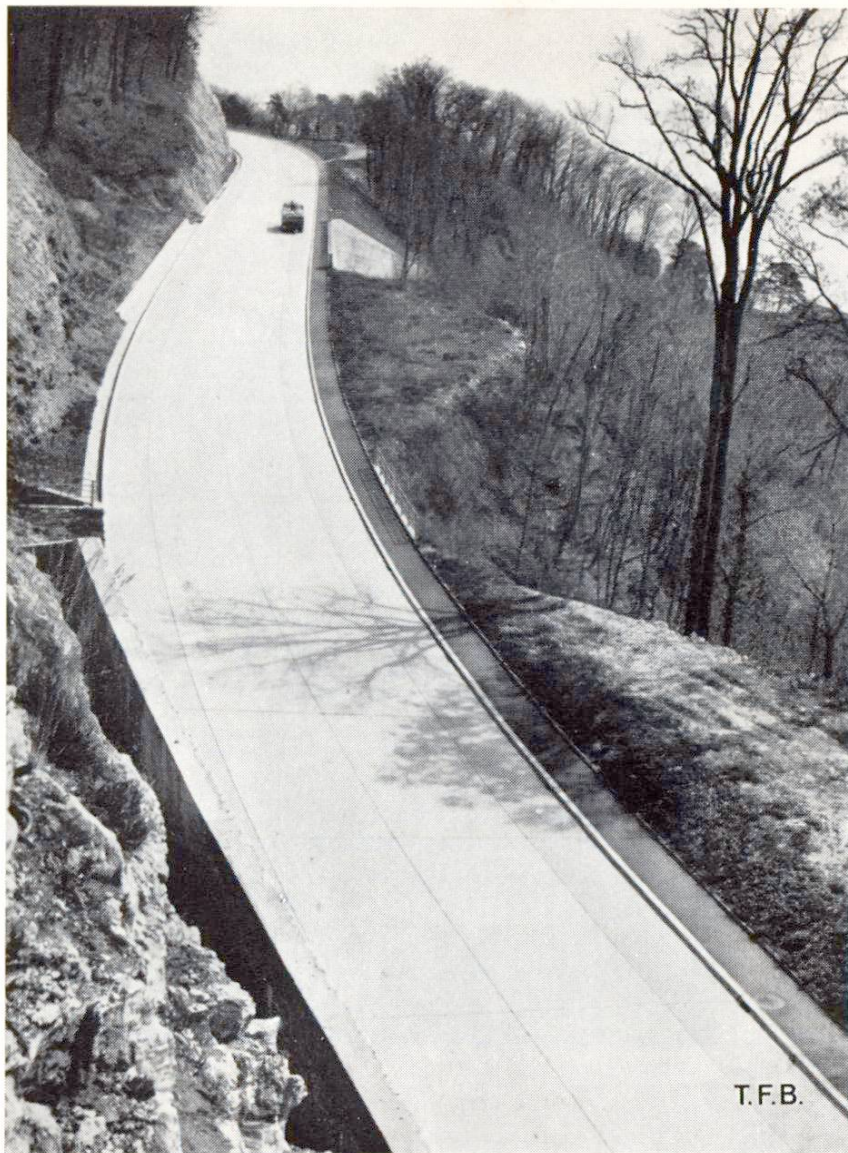
Abb. 12 Eindrückliche Streckenführung der neuen Betonstrasse bei Concise am Neuenburgersee. Helle Betonfahrbahn und rotgetönte Beton-Fahrradstreifen
