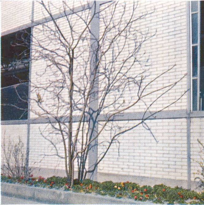
Mit Kalksandsteinen ausgefachte Stahlkonstruktion einer Fabrikhalle
