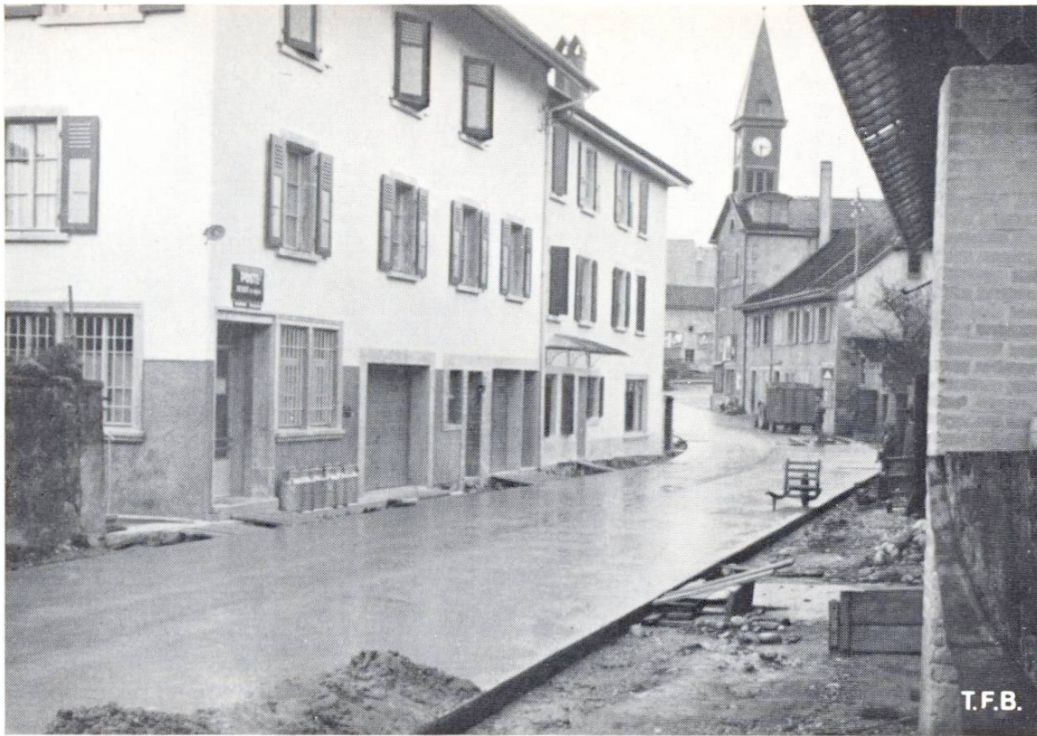
Abb. 9 Die betonierte Güterwege werden sehr oft ins Dorf hinein verlängert
