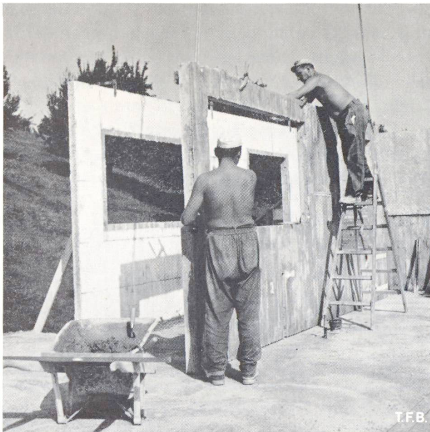
Abb. 3 Montage von auf der Baustelle vorgefertigten Betonelementen. Die Aussenwandteile werden hier aus zwei kongruenten Betonplatten gebildet, wobei die äussere bereits mit einer Isolationsschicht belegt ist. Die doppelte Ausführung lässt sich vermeiden, indem für den Beton ein wärmedämmender Leichtzuschlag, z.B. Leca, verwendet wird. Man erkennt auch die Aussparungen im Beton der Innenwand für die Installationen. Diese sind genau eingeplant und wurden mittels Holz- oder Schaumstoffeinlagen erhalten.
