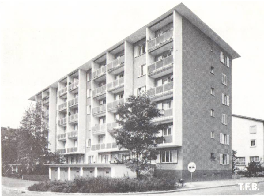
Abb. 1 Wohnhaus in Dietikon ZH, vollständig erstellt aus Betonelementen, die auf der Baustelle vorgefertigt worden sind (Projekt und Ausführung: D. Lanfranconi, Zürich).
