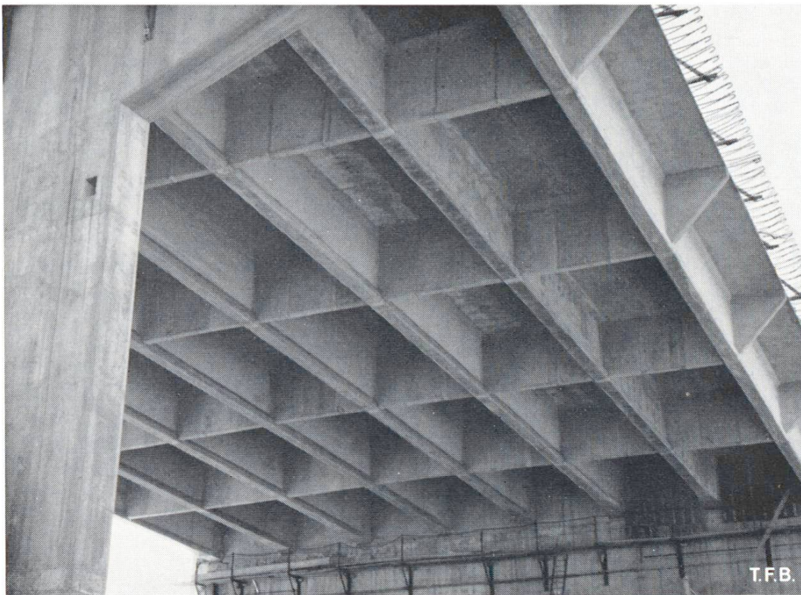
Abb. 5: Blick unter die Brückenplatte. Man erkennt deutlich die Arbeitsfugen zwischen den vorgefertigten T-Balken und dem zur Verbindung eingebrachten Ortsbeton.
