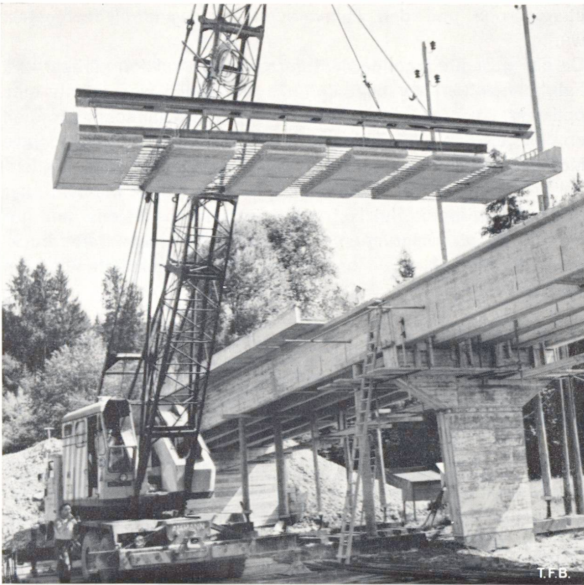
Abb. 6 Montage der Fahrbahnplatten
