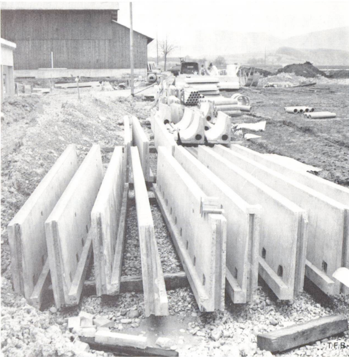
Abb. 1 Verschiedene Bauelemente warten auf den Einsatz. Im Vordergrund Platten für die Mistrinne mit Schubstangenentmischung, dahinter vorfabrizierte Krippen.
